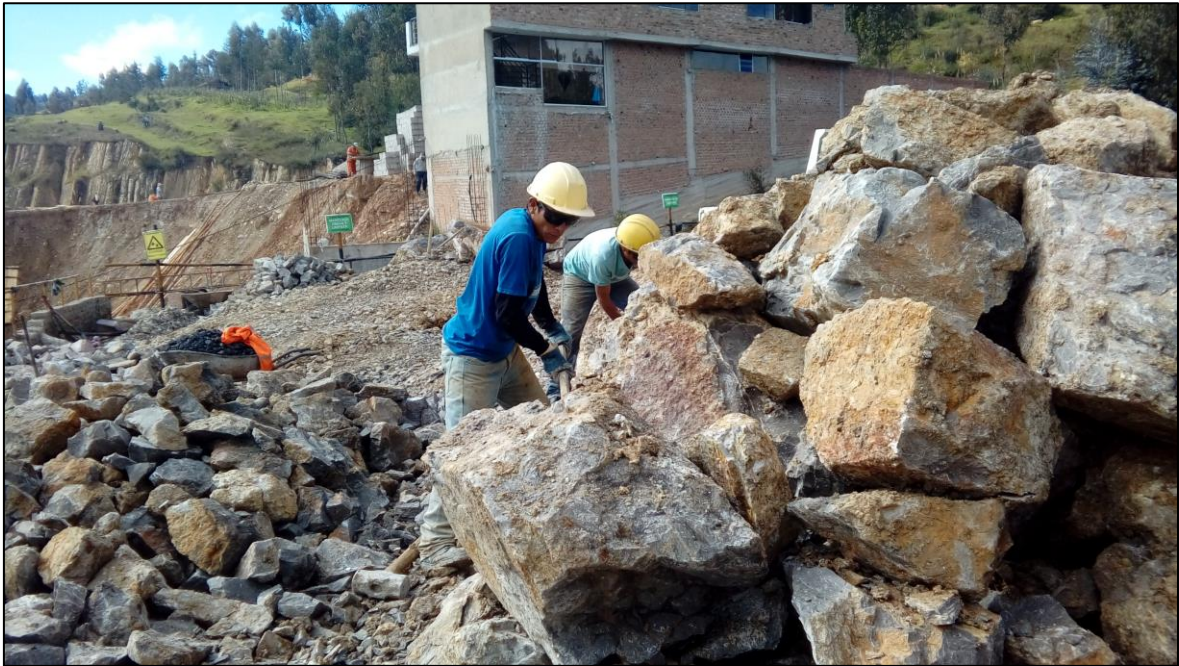
Figura 51. Chancado de roca caliza.
