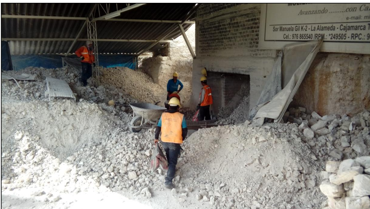
Figura 14. Descargue de los hornos de calcinación. Fuente: Elaboración propia, (2017).
