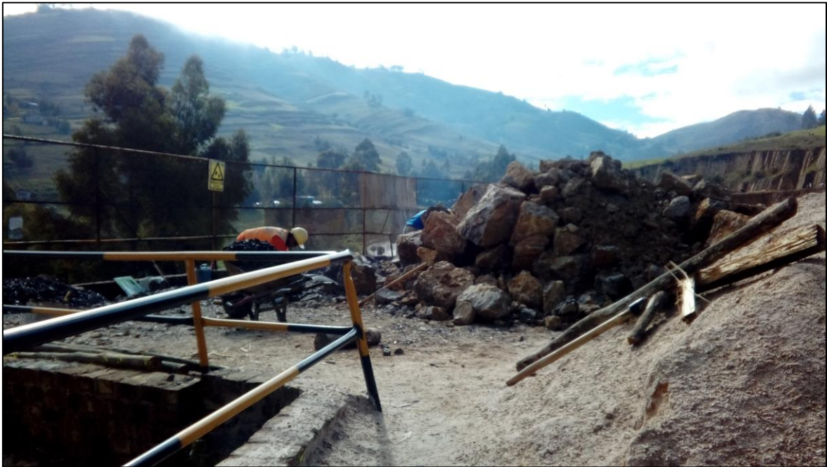
Figura 45. Operaciones de calcinación de roca.
