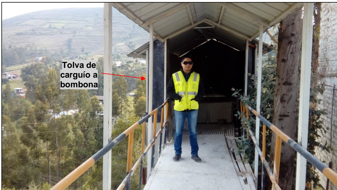
Figura 17. Zona de despacho de óxido de calcio molido.
