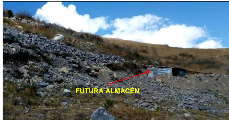
Figura 6. Zona donde se construirá el almacén en la concesión Juan de Dios I (actualmente se encuentra una edificación improvisada con materiales reciclados, la cual será demolida).
