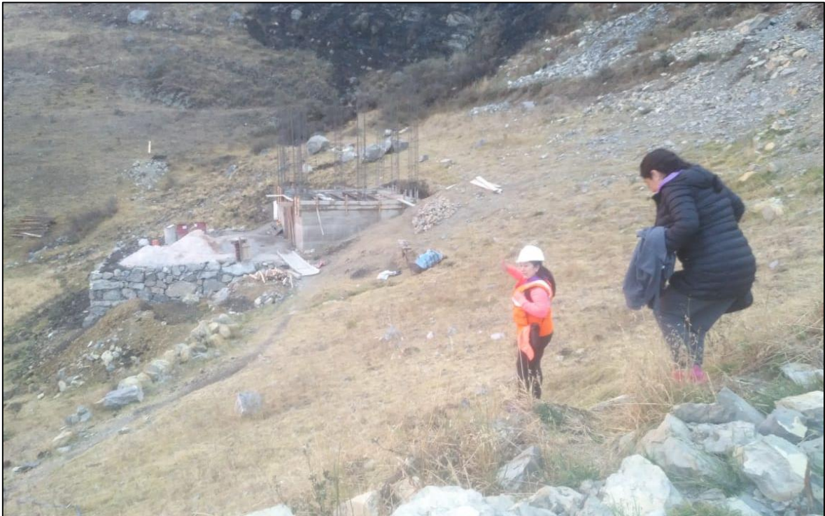
Figura 13. Construcción en stand by en la concesión Juan de Dios I.
