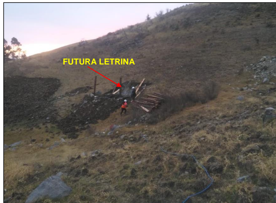
Figura 7. Zona donde se implementará la letrina en la concesión Juan de Dios I.
