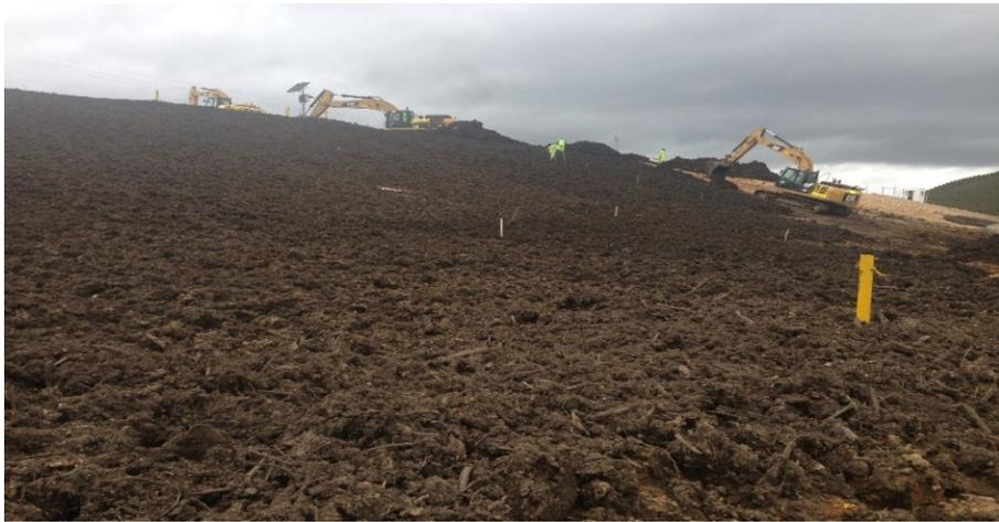
Foto 2: Maquinaria disponiendo el Tecnosol sin ser compactado.
