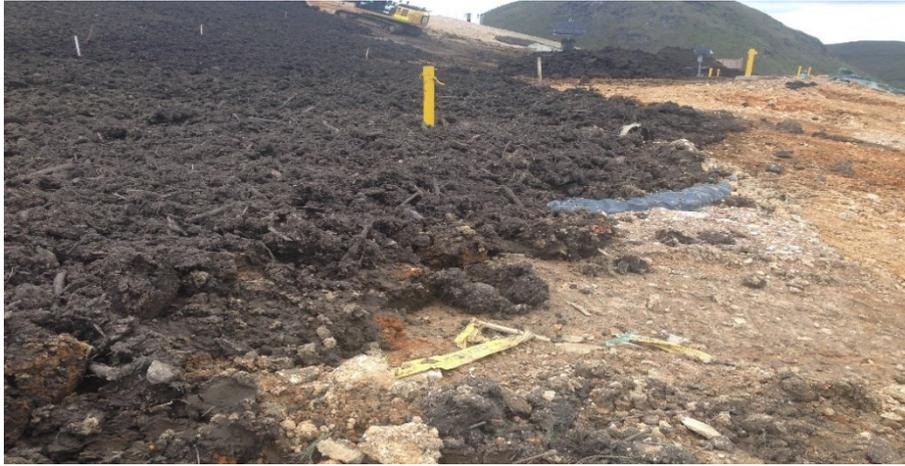
Foto 1: Disposición del Tecnosol Ándico como primera capa correspondiente a la 3ra hectárea.
