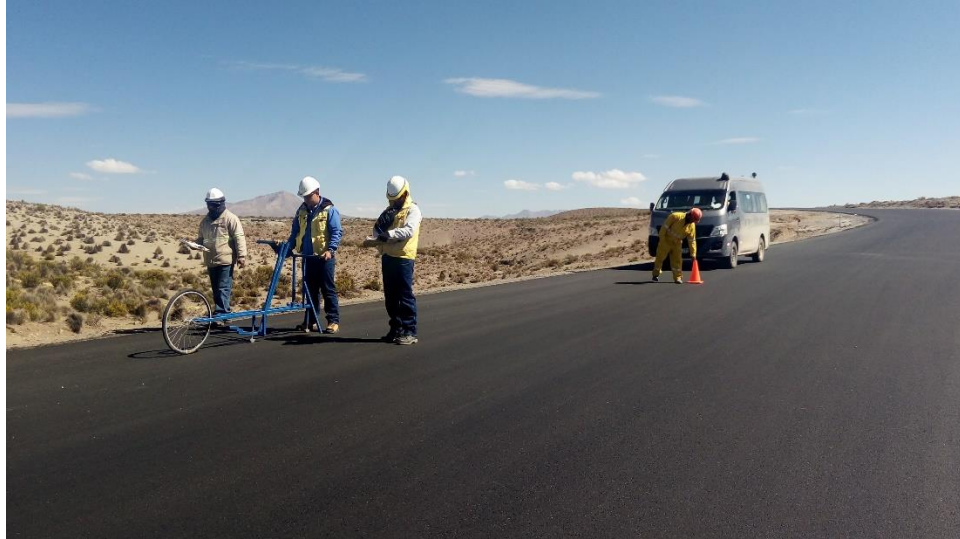
Imagen 9. Ensayo de Índice de Rugosidad Internacional con la presencia de la Supervisión de obra.
