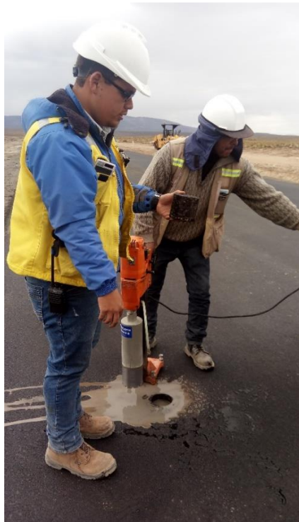
Imagen 10. Extracción de briqueta de la carpeta asfáltica con presencia de la Supervisión.
