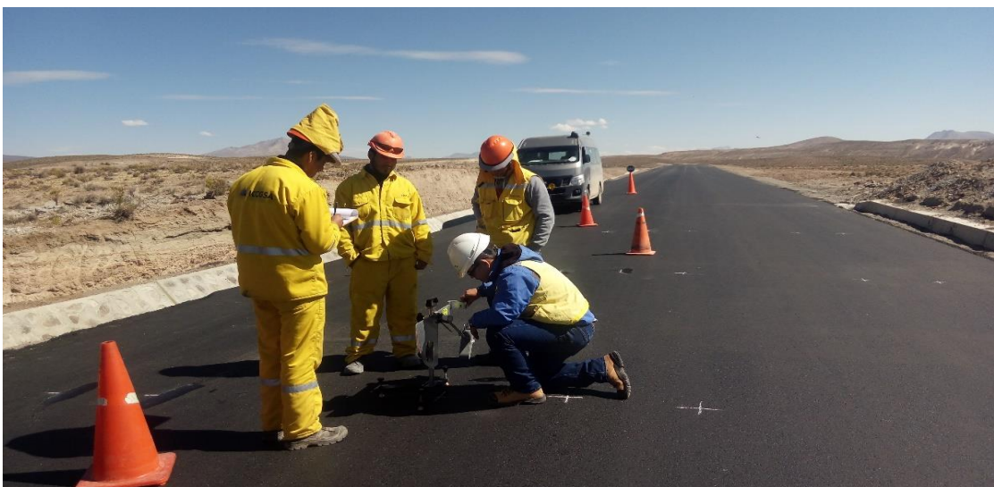
Imagen 11. Ensayo de Coeficiente de resistencia al deslizamiento con el péndulo del TRRL con su respectiva señalización de seguridad.
