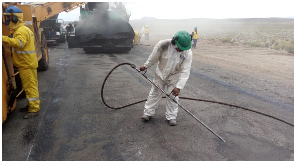
Imagen 6. Control de limpieza y sopleteo mediante un compresor de aire, la cual nos permite una mejor adherencia entre la base granular imprimada, el material ligante y la mezcla asfáltica.
