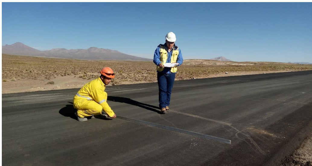
Imagen 8. Ensayo de Lisura realizada con la regla de tres metros.
