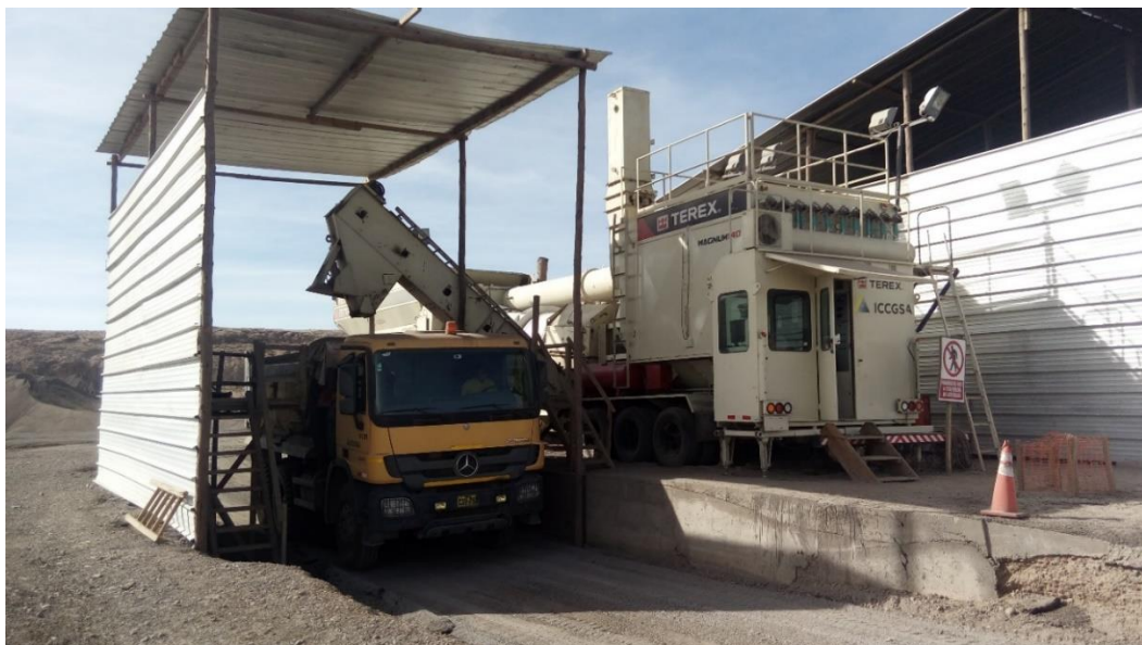
Imagen 13. Vista parcial de la planta de asfalto TEREX – Magnum 140.
