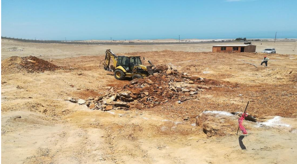
Foto 1. Excavación de Corte de Roca de Plataforma de Planta Industrial.
