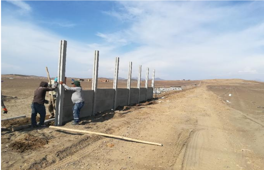
Foto 7. Isaje de Placas y Postes Prefabricados.
