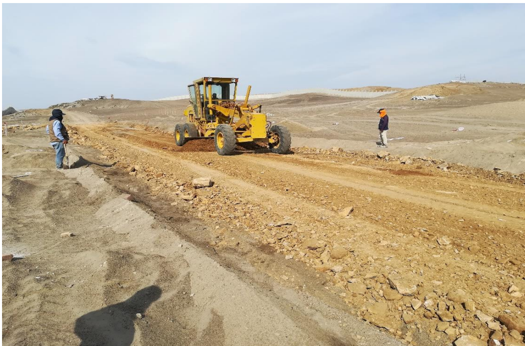
Foto 4. Motoniveladora en Acceso de Planta Industrial.
