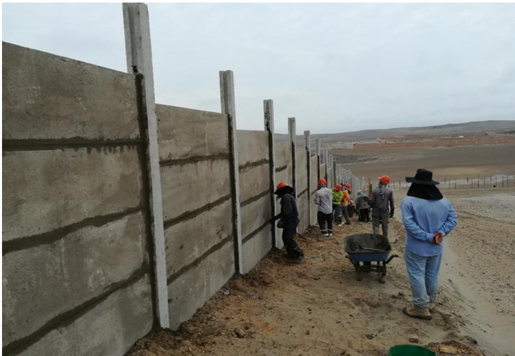
Foto 8. Solaqueo o Recubrimiento de Conexiones Placa-Placa y Placa-Poste
