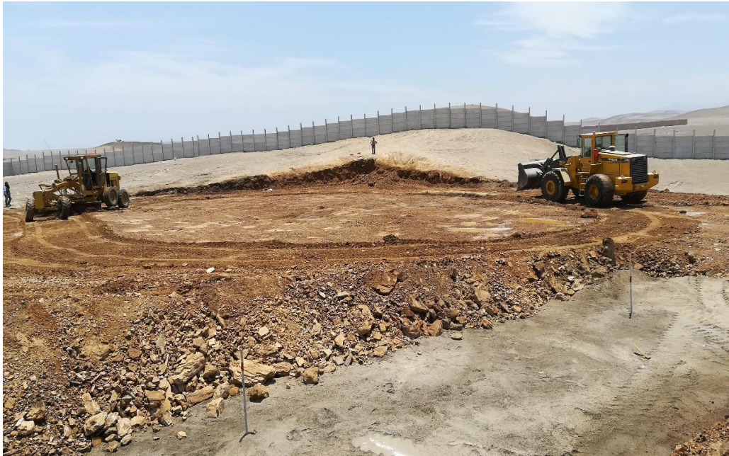
Foto 3. Motoniveladora en Plataforma de Planta Industrial.
