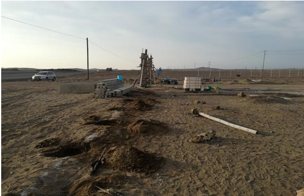
Foto 5. Excavación de Cimientos de Columnas para el cerco perimétrico.
