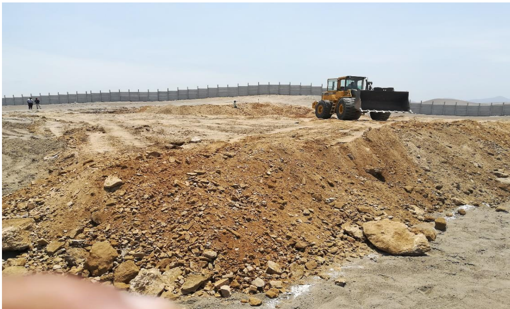
Foto 2. Relleno de Plataforma de Planta Industrial.
