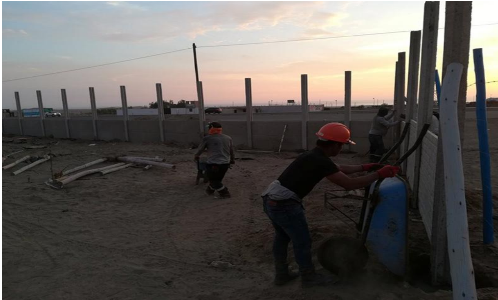
Foto 6. Vaciado de cimientos de postes del cerco perimétrico.
