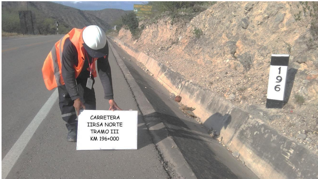
Foto nº 11: Inicio de Tramo 3 - Km 196+000
