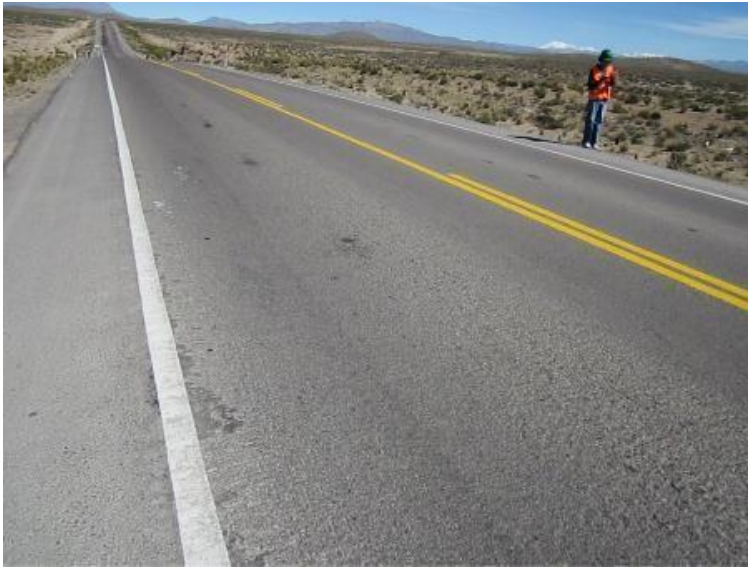
Foto n° 5: Pulimento de agregados.
