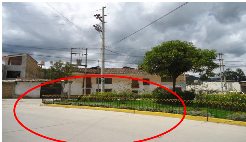
Figura 4: Parte estructural externa de la planta de procesos de la empresa,.
