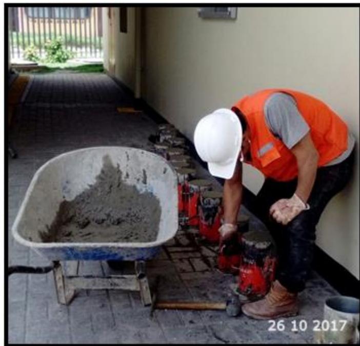
Foto 30: Colocación de la mezcla de concreto en los moldes.
