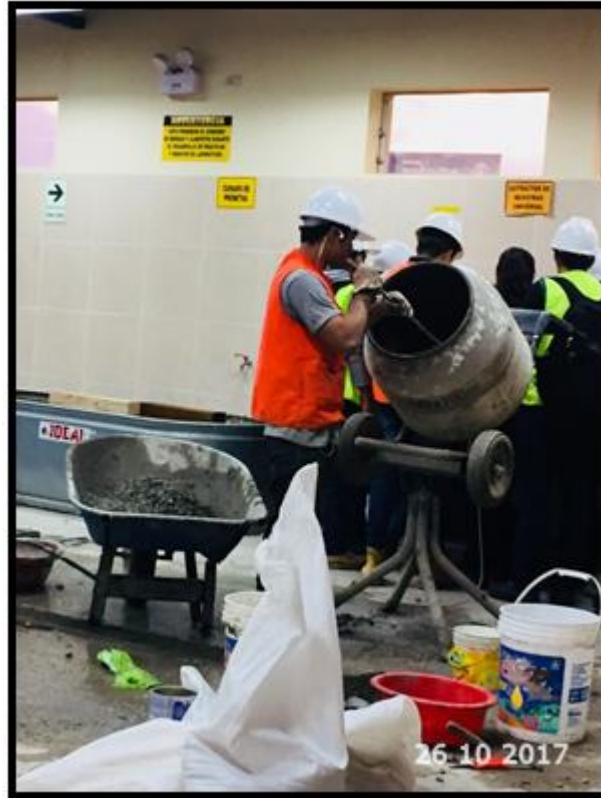
Foto 29: Apuntalamiento en la mezcladora para que los agregados y la fibra de vidrio se adhieran de forma uniforme.
