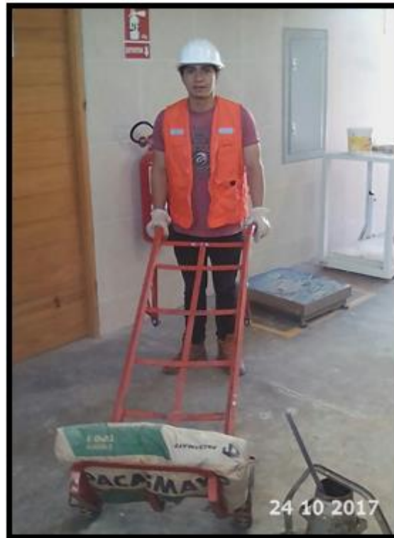
Foto 25: Traslado de material para comenzar con la preparación de la mezcla.
