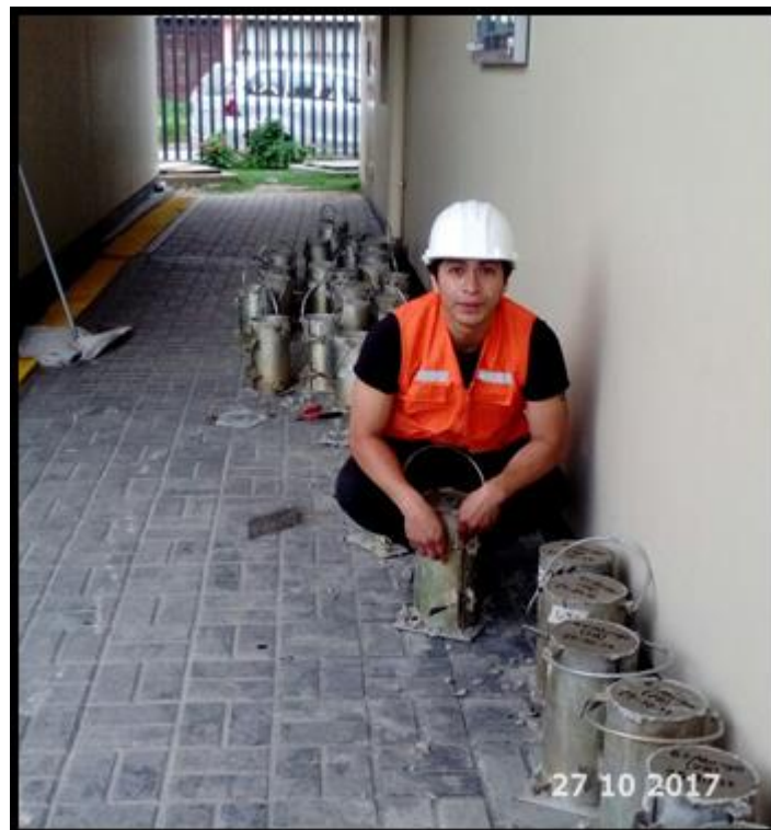
Foto 32: Desencofrado de las probetas, para luego ser curados.
