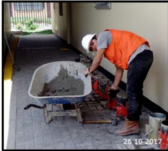
Foto 31: Colocación de la mezcla de concreto en los moldes.
