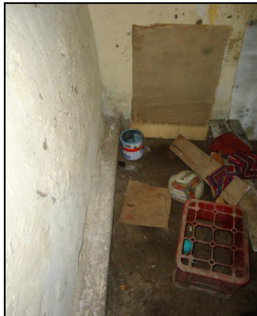
(H7): Muro de ladrillo lateral derecho (eje E-E) en baño, cara interiores afectados por humedad.
