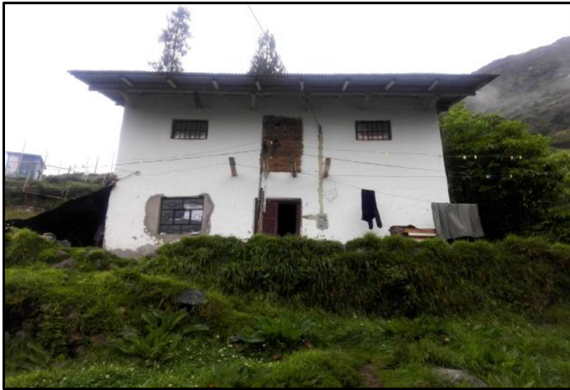
02. No se evidencian desplomes de muros
