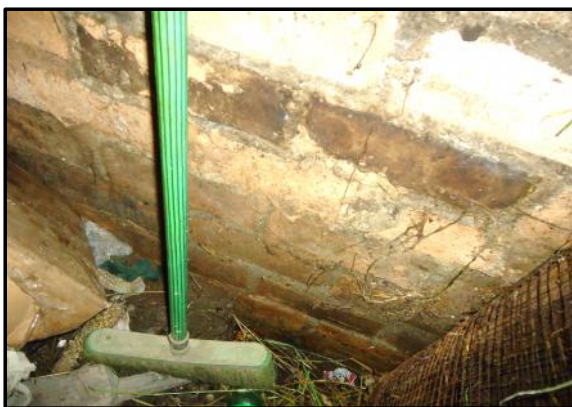
(H8): Muro de ladrillo de fondo (eje 2-2) en galpón, cara interior afectada por humedad.
