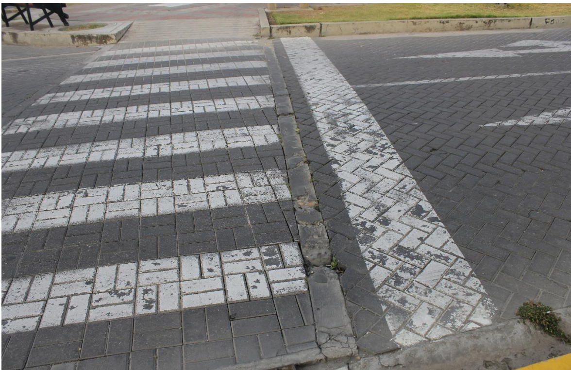
Figura 19. Falla de fracturamiento de confinamiento interno en la Av. Huáscar (Tramo Km00 + 100 – Km00 + 150)
