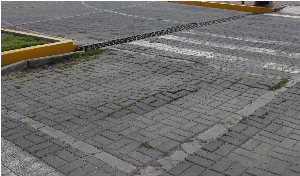
Figura 28. Falla de abultamiento, ahuellamiento y fracturamiento de confinamiento externo en la Av. Manco Cápac (Tramo Km00 + 400 – Km00 + 450)
