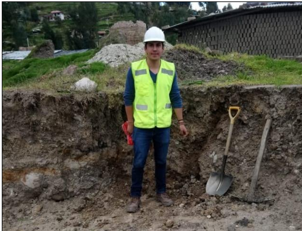
Fotografía 4: Segunda visita a la cantera “El Cerrillo”, extracción de muestra para ensayos de proctor modificado y CBR
