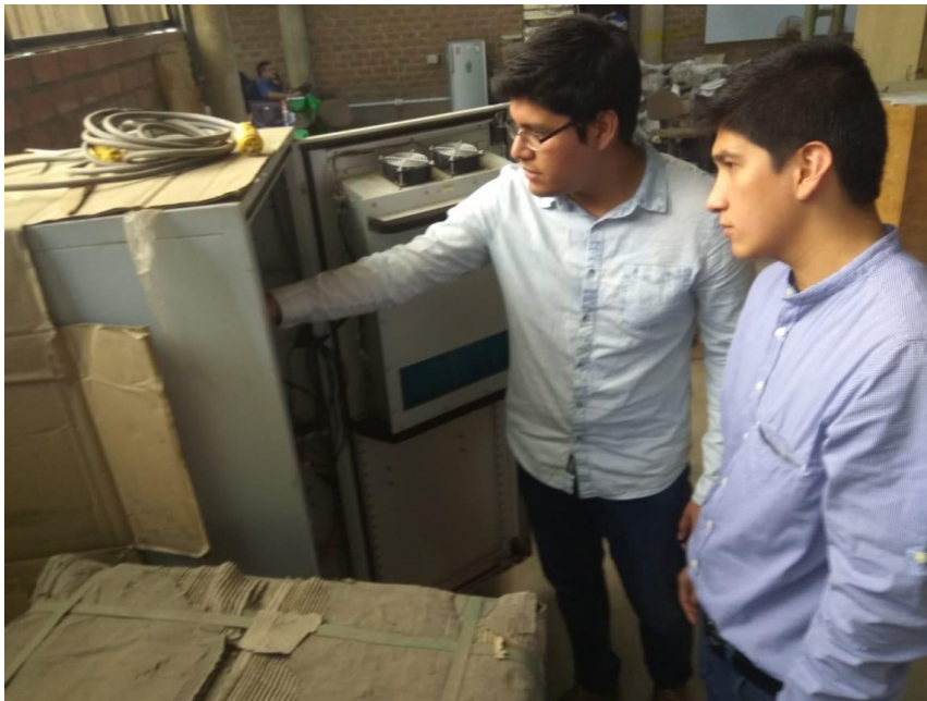
Figura n.º 20. Observación de un gabinete outdoor por parte de los autores
