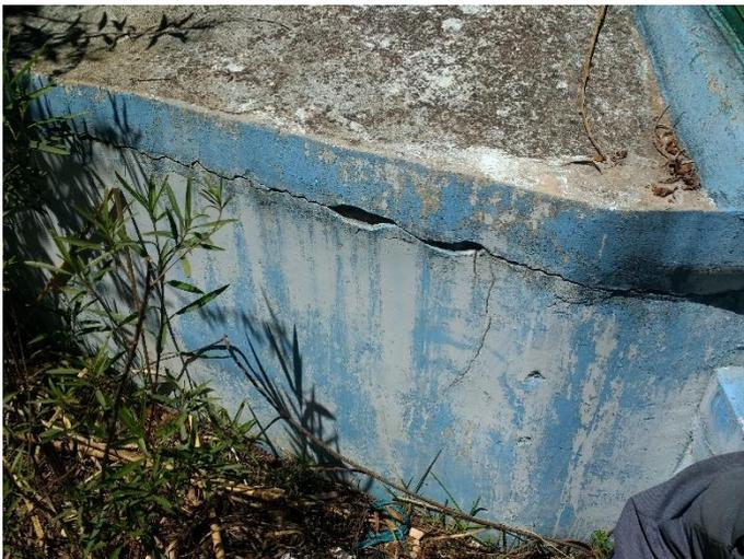
Captación con fisuras en la estructura.
