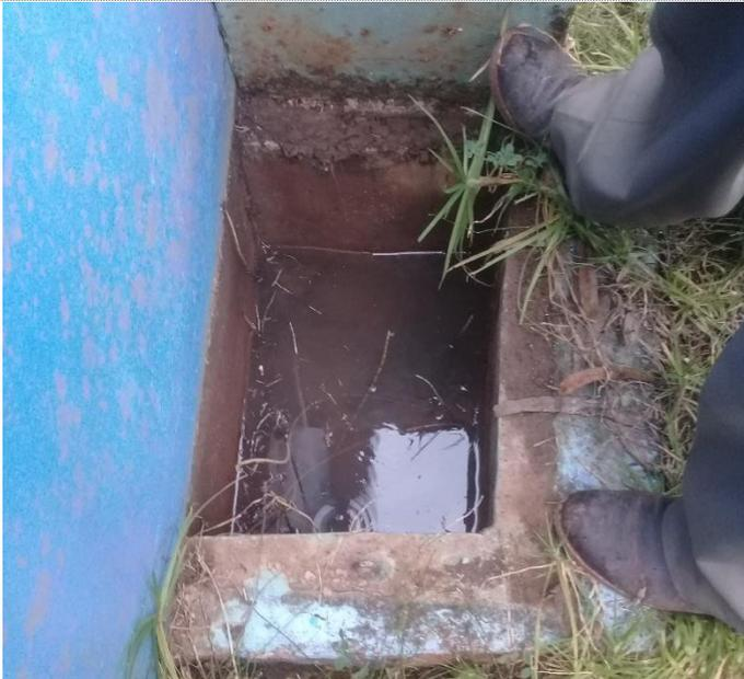
Caja de válvulas inundada. En todas las estructuras se observa un exceso de agua filtrada desde el propio suelo.
