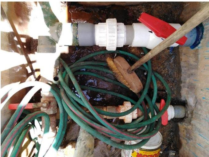
Caja de válvulas usada como almacén. En el fondo se encuentra mucha humedad, por filtración del mismo terreno.
