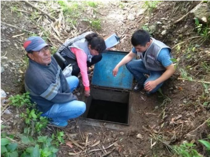
Cámara húmeda por debajo del nivel de suelo, en época de lluvia se inunda y filtra agua contaminada al sistema.
