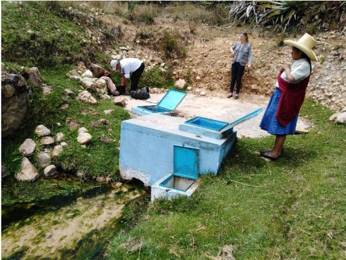
Captación desprotegida, caja de válvulas inundada. Esta misma captación abastece de agua para el sistema de riego. Se encontraron raíces vegetales en la cámara húmeda.
