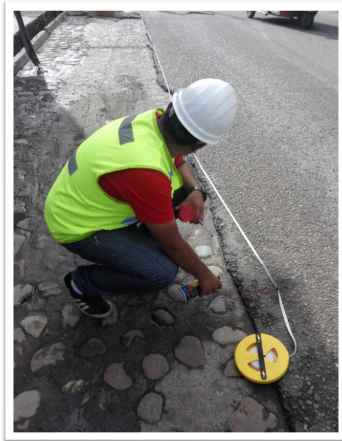
Fotografía N° 20: Medición de hueco en Unidad 25
