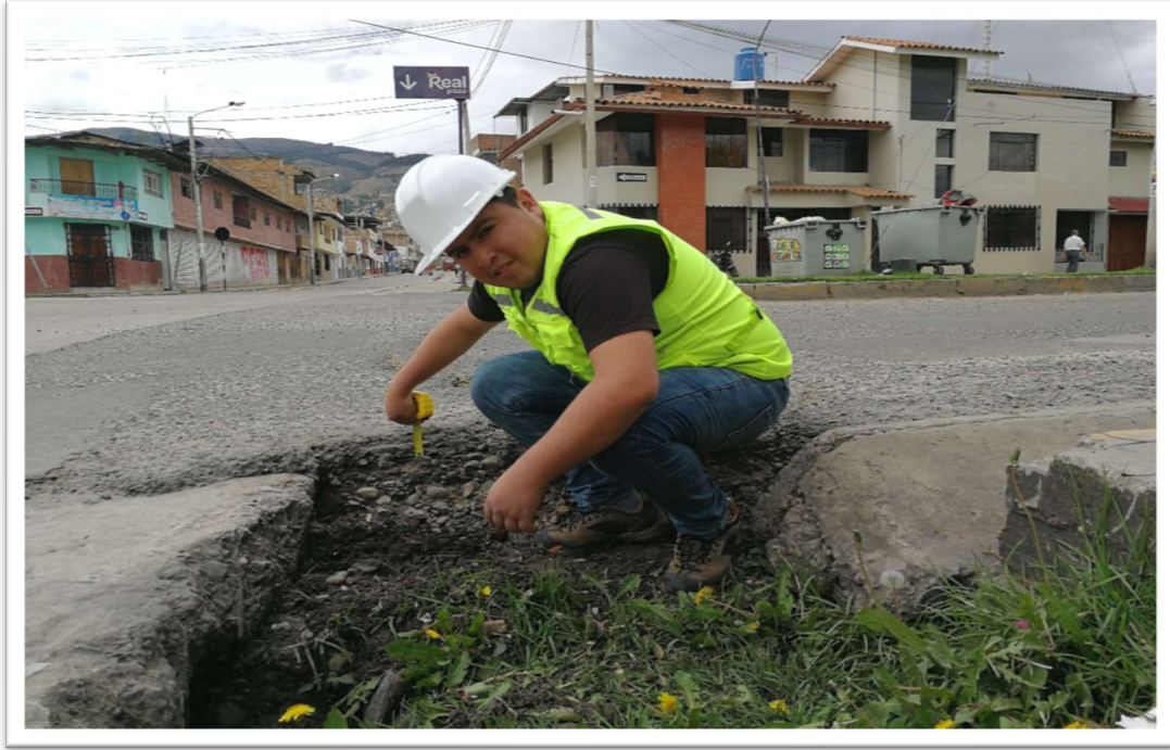
Fotografía N° 37: Perfil de pavimento
