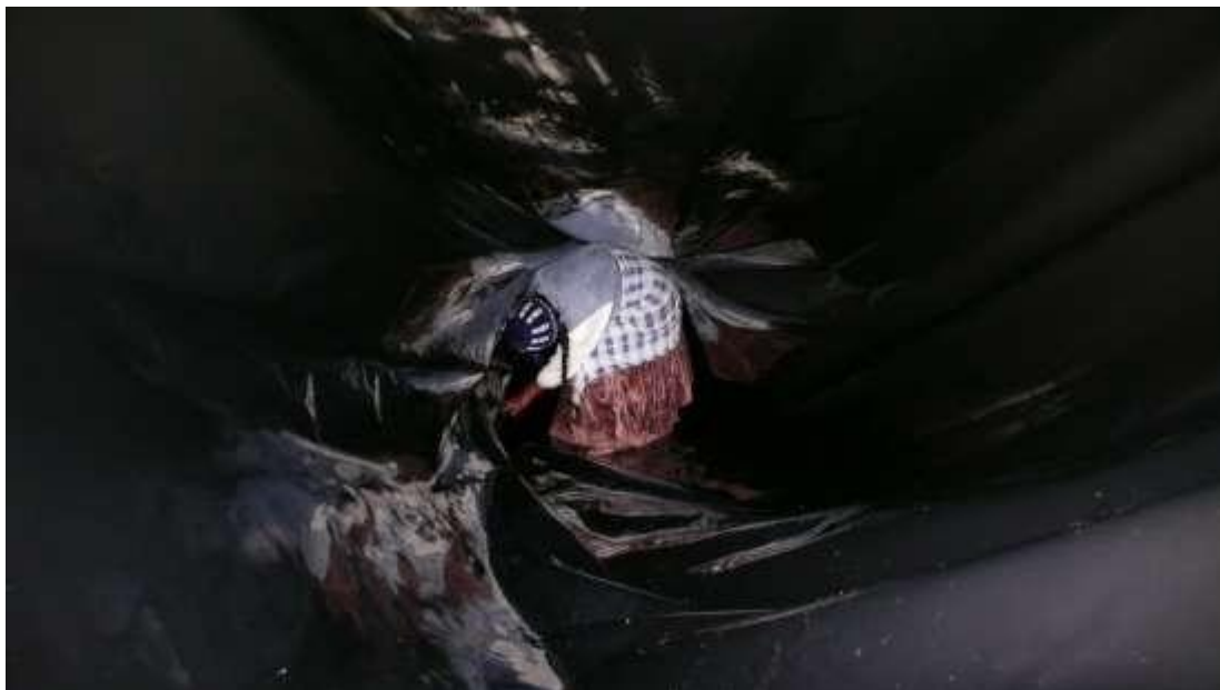
Figura 7. Colocación del biodigestor
