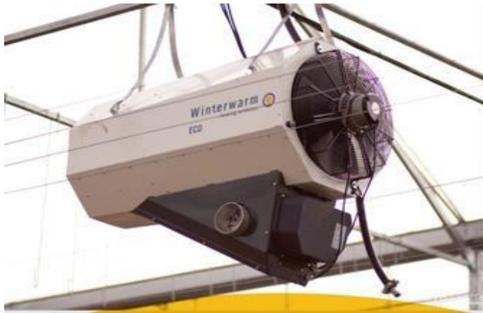
Figura 3. Nos muestra la calefactora que se utilizara en el sistema de climatización.
