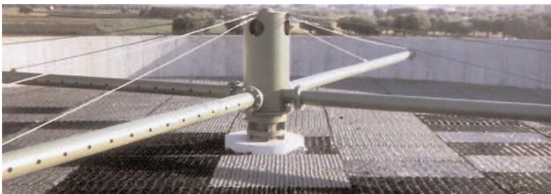
Imagen 22: Vista de un sistema de distribución rotatorio para Filtros percoladores.
