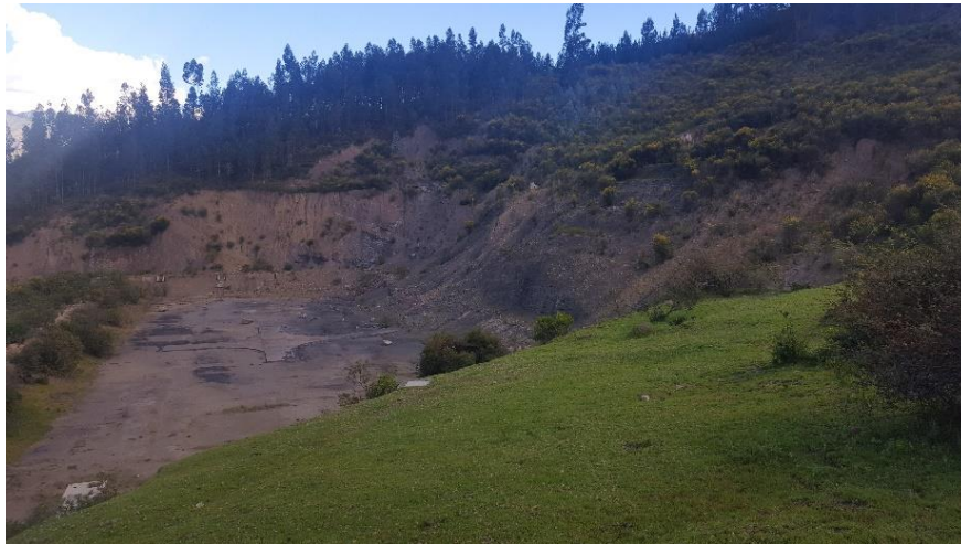
Foto 5: Deslizamiento de terreno sobre laguna en abandono
