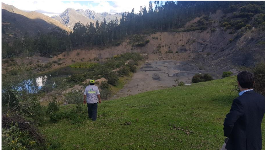
Foto 4: lagunas en estado de abandono
