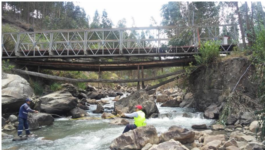
Foto 8: Sección del Rio Huayochaca - Puente Cardonyoc
