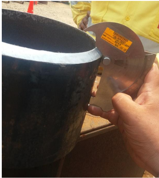
Figura 10: Preparación de bisel
