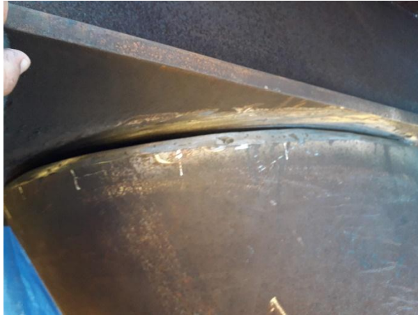
Figura 9. Remoción de material aportado
