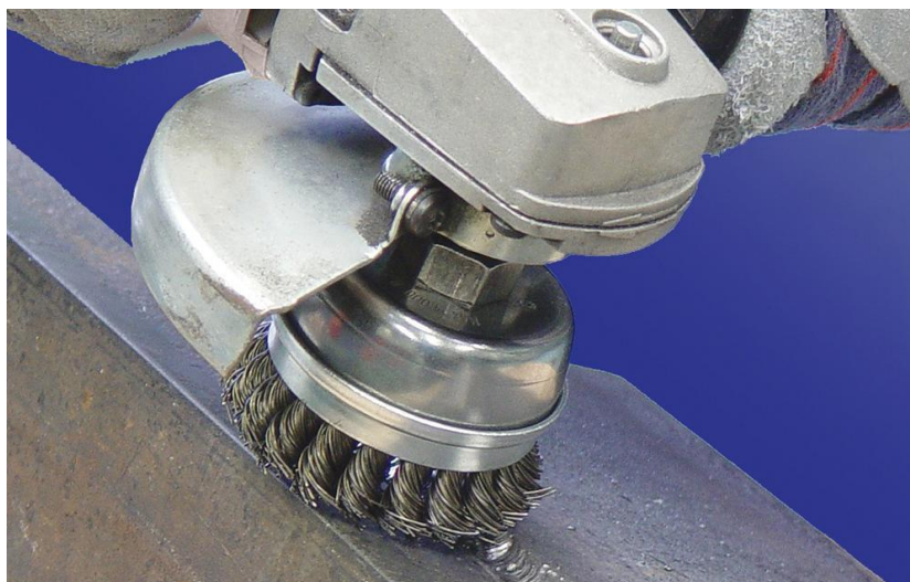
Figura 12. Limpieza de soldadura con cepillo de acero.
