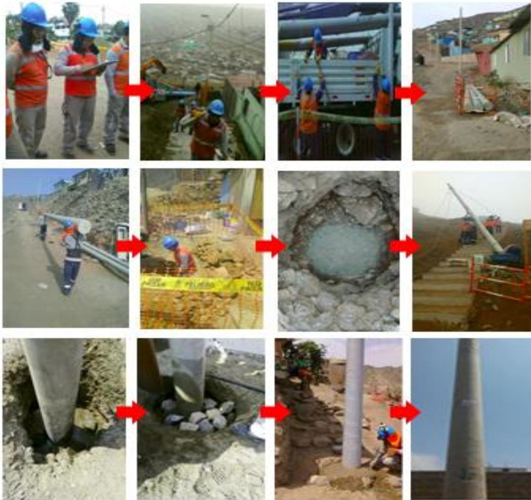
Figura 0.21 Pasos del proceso la instalación de poste
