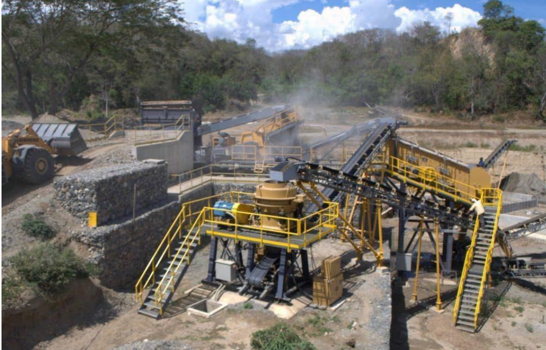
Figura n.º 1. 1 Planta estacionaria de procesamiento de agregados
