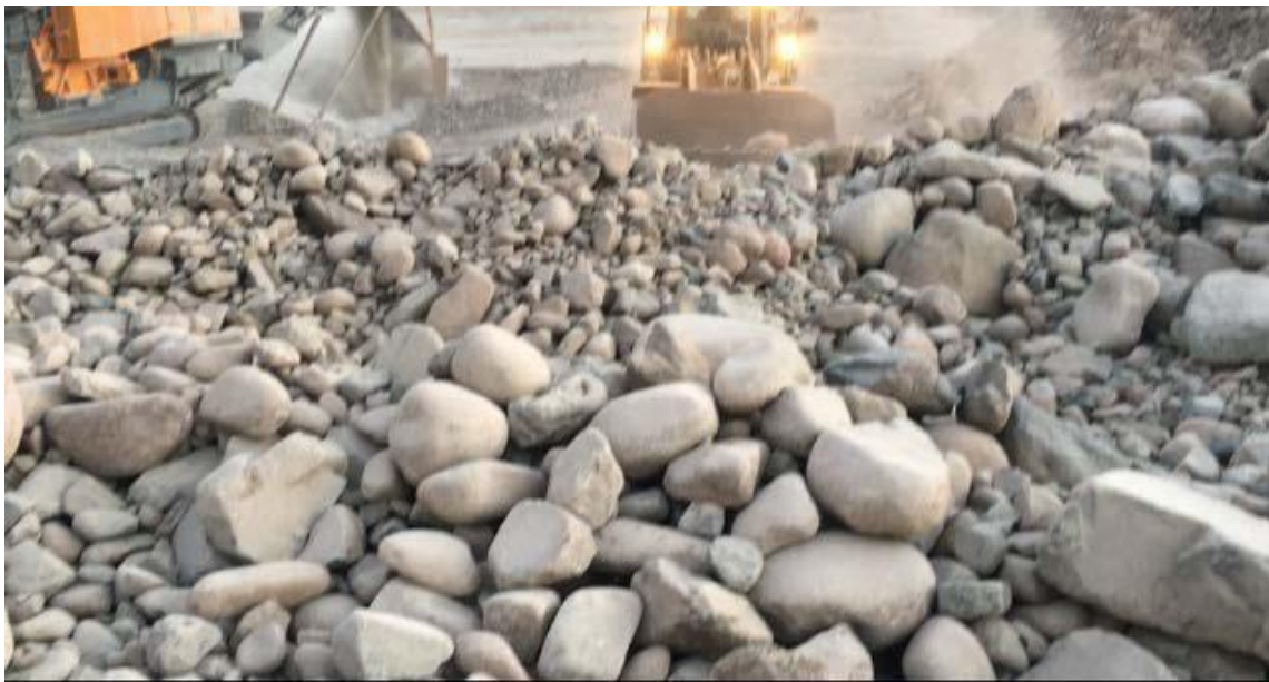
Figura n.º 3. 19 Acopio de piedra selecta, presencia de tamaños >5"
