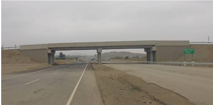
Ilustración n.º 19.- Puente sobre el Intercambio Vial Huaura construido.
