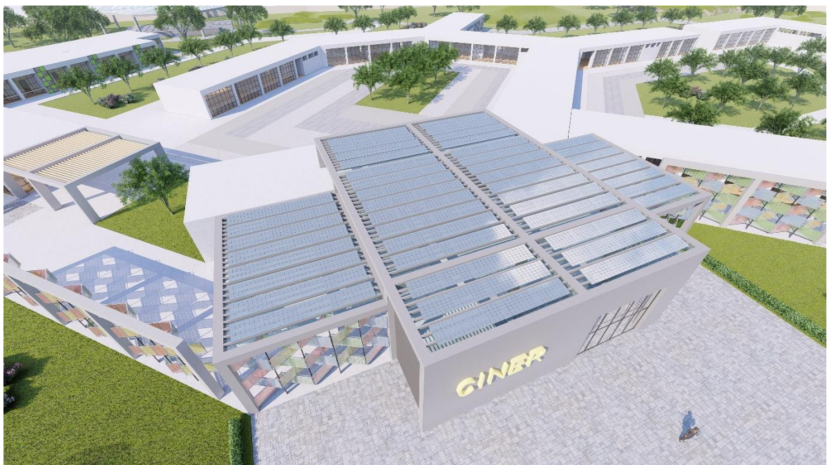
Figura N°21: Vista de paneles solares integrados a la cubierta
