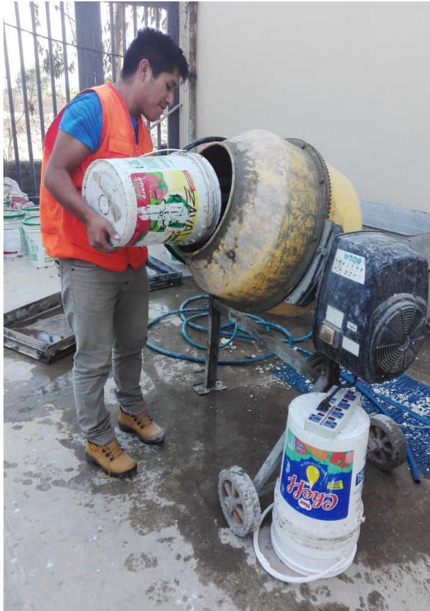
Figura 31: Mezcla del concreto
