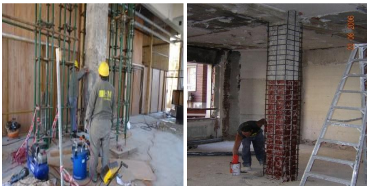
Foto 2: Apuntalamiento de la losa, Fuente: Google
