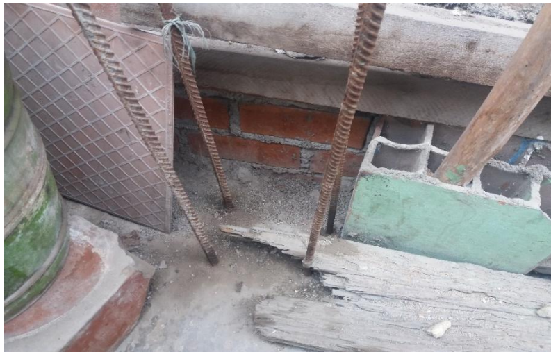
Foto 12: Acero corrugado de columna, fuente: Propia
