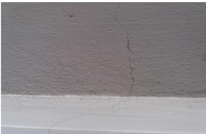
Foto 11: grietas en vigas, Fuente: Propia
