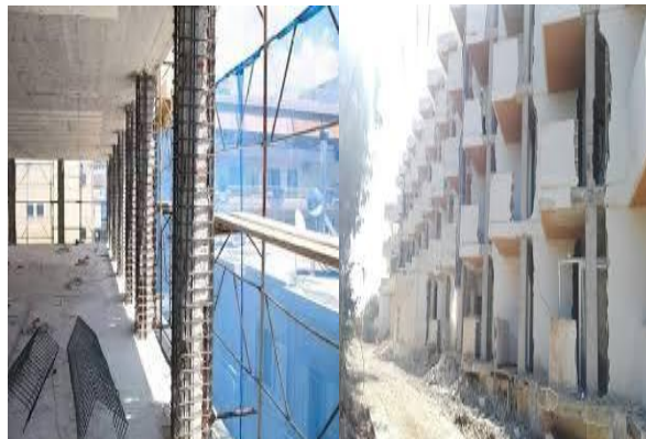
Imagen 5: Técnica del encamisado, Fuente Wikipedia
