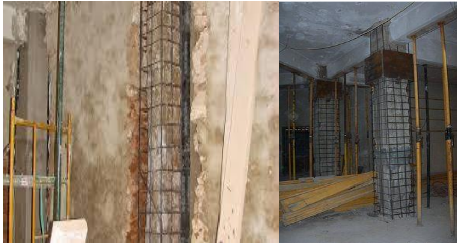
Foto 3: Encamisado de columnas, Fuente: Google
