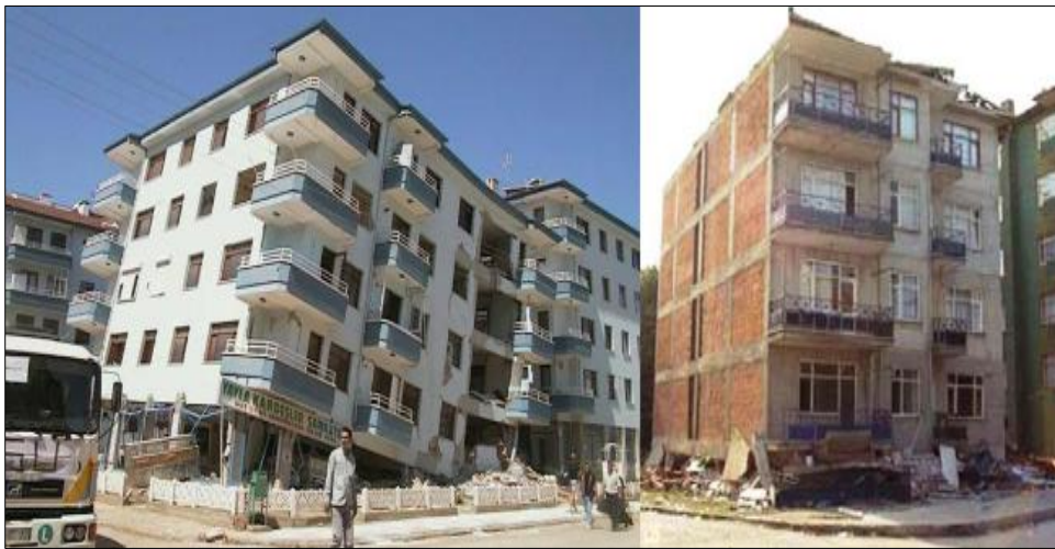
Foto 6 : falla por flexión, Fuente Google.com
