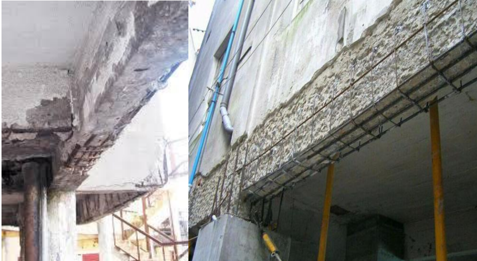
Foto 4: Encamisado de viga, Fuente: Google
