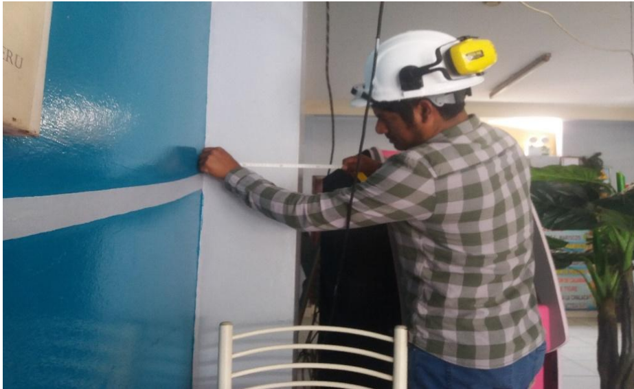
Foto 8: medición de columna, Fuente: Propia
