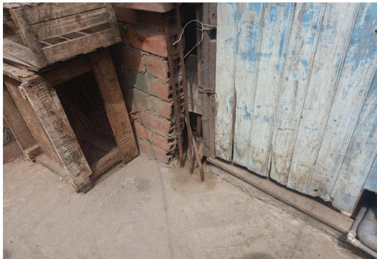
Foto 13: acero de columna central, fuente: propia
