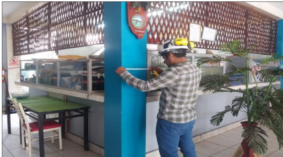
Foto 9: Medición de columna central, Fuente: Propia
