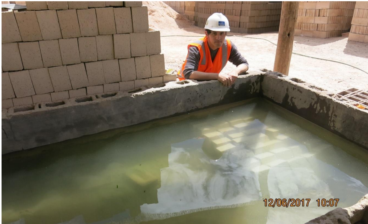
Figura 13: Ladrillos sumergidos en poza de curado
