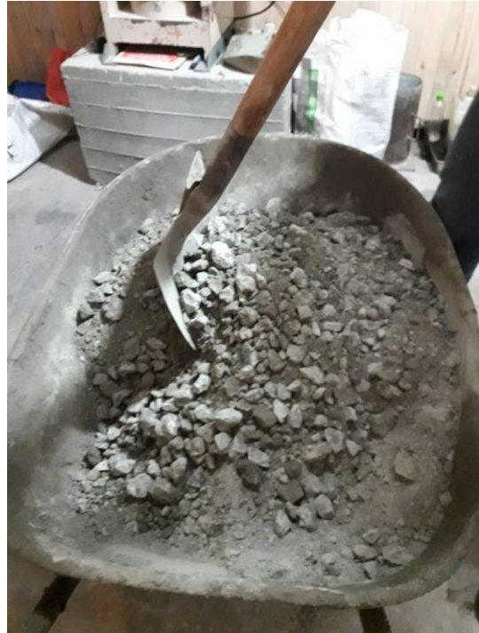
Fig. 6: Mezclado del concreto reciclado
