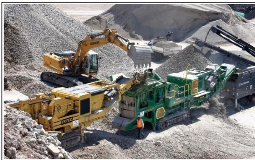
Figura N° 2. Planta de tratamiento de escombros en México
