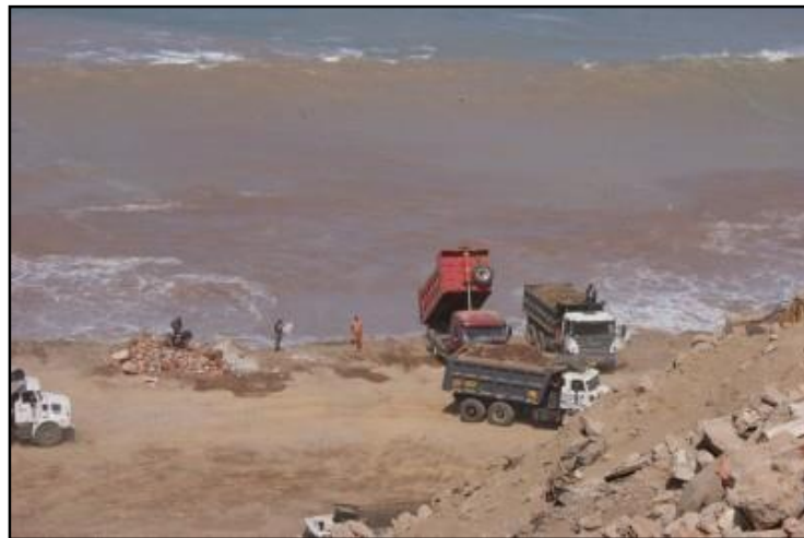
Figura N° 7. Contaminación de la Costa Verde con RSCD
