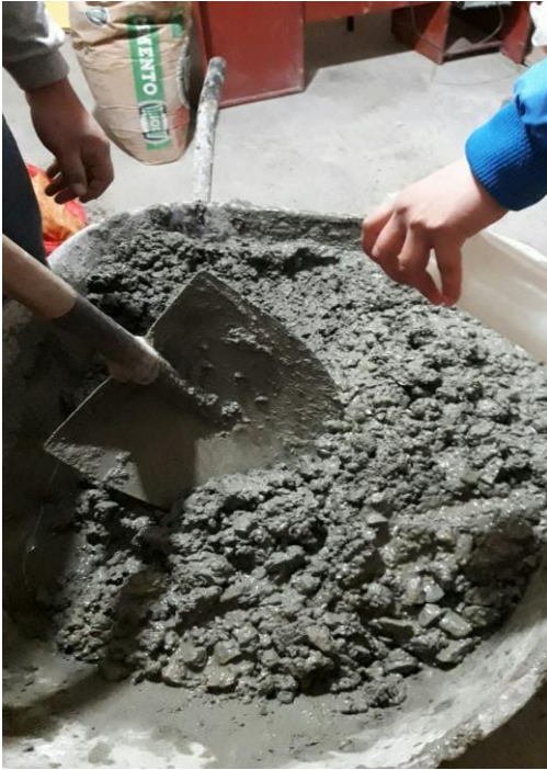
Fig. 5: Mezclado del concreto patrón
