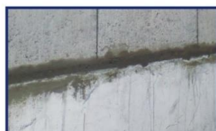
Nivelamiento primera hilada
