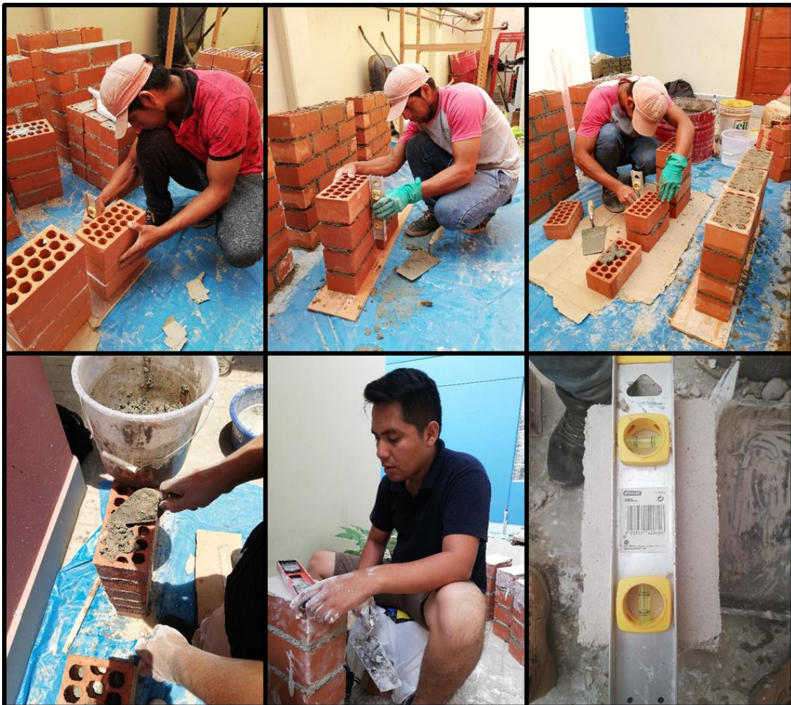
Figura 81: Elaboración y refrentado de pilas
