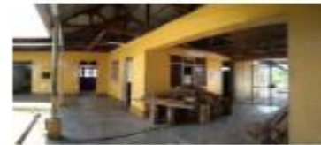
Falta colocación de vidrios en puertas y ventanas.
