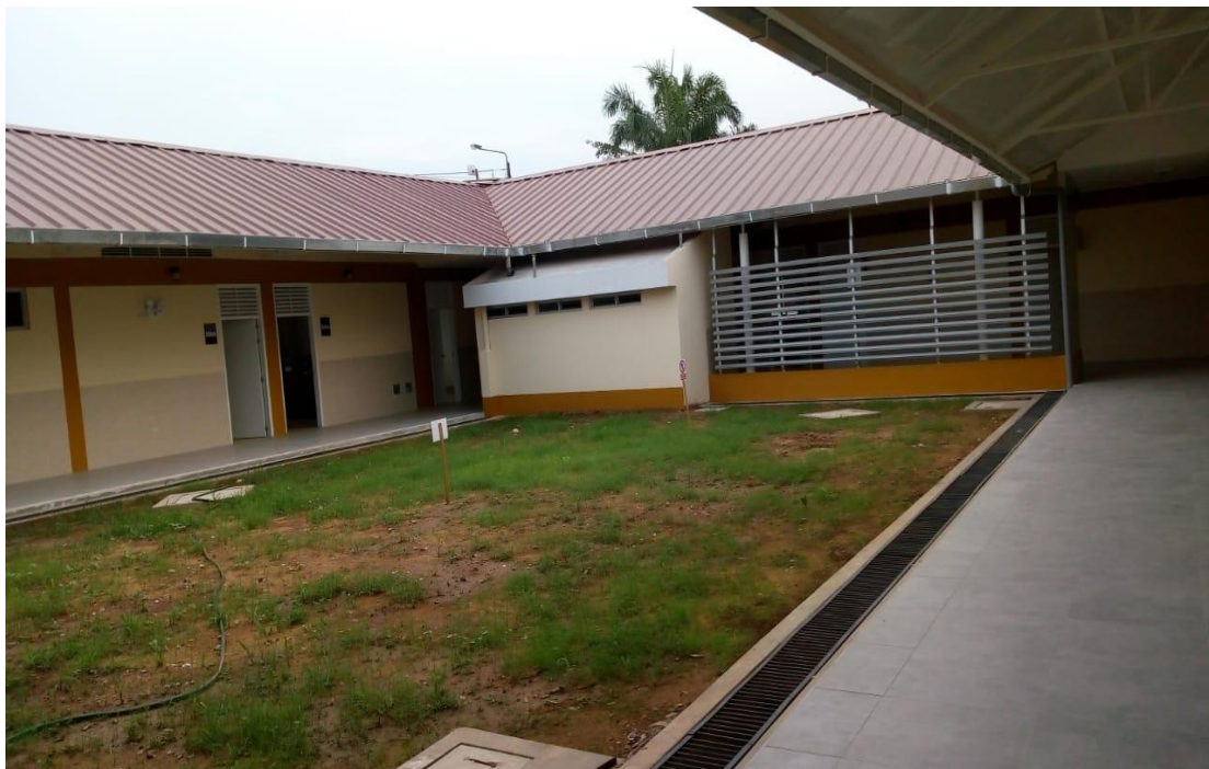
Figura 15. Patio interior del Módulo A Fuente: Elaboración Propia
