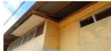
Falta colocación de vidrios en puertas y ventanas.
