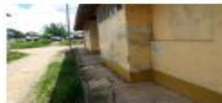
Falta cerco perimetrico, cuneta pluvial y veredas perimetricas.
