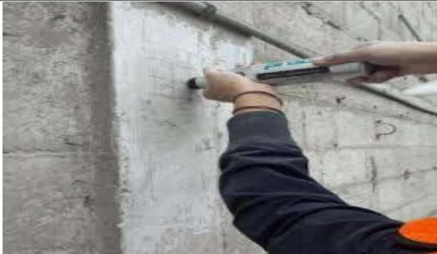
Figura 12. Uso de Esclerómetro para medir la resistencia del concreto Fuente: Elaboración Propia
