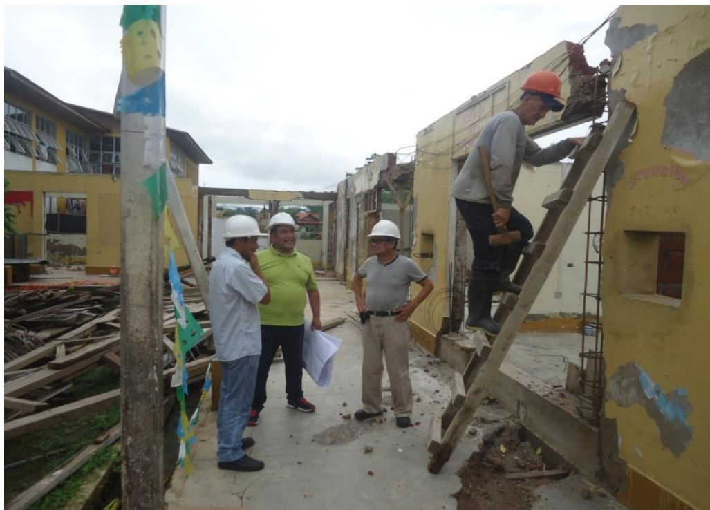
Figura 11. Evaluación estructura Fuente: Elaboración Propia
