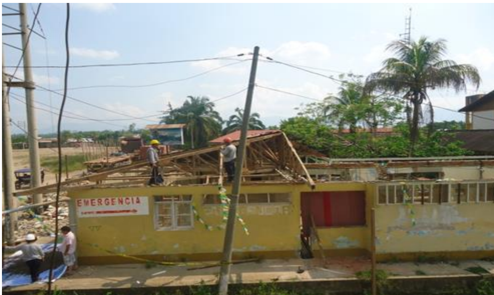
Figura 6. Desmontaje de cobertura (techo) Fuente: Elaboración Propia
