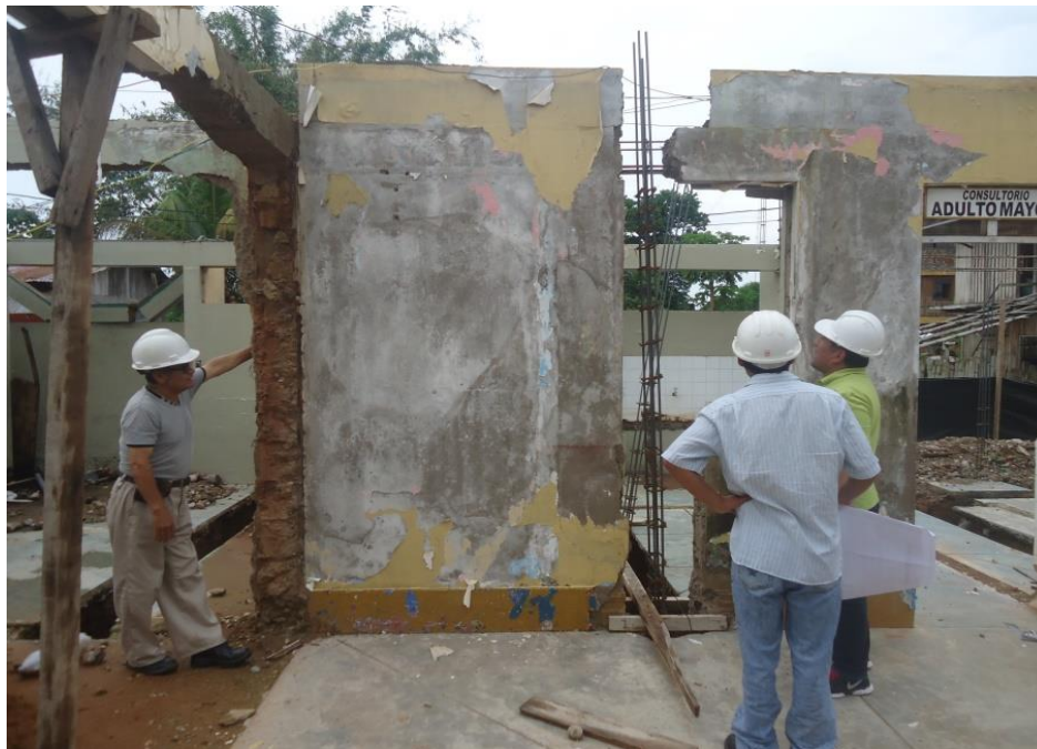
Figura 9. Demolición de muros Fuente: Elaboración Propia
