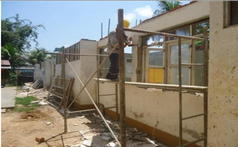
Figura 7. Desmontaje de puertas y ventanas Fuente: Elaboración Propia
