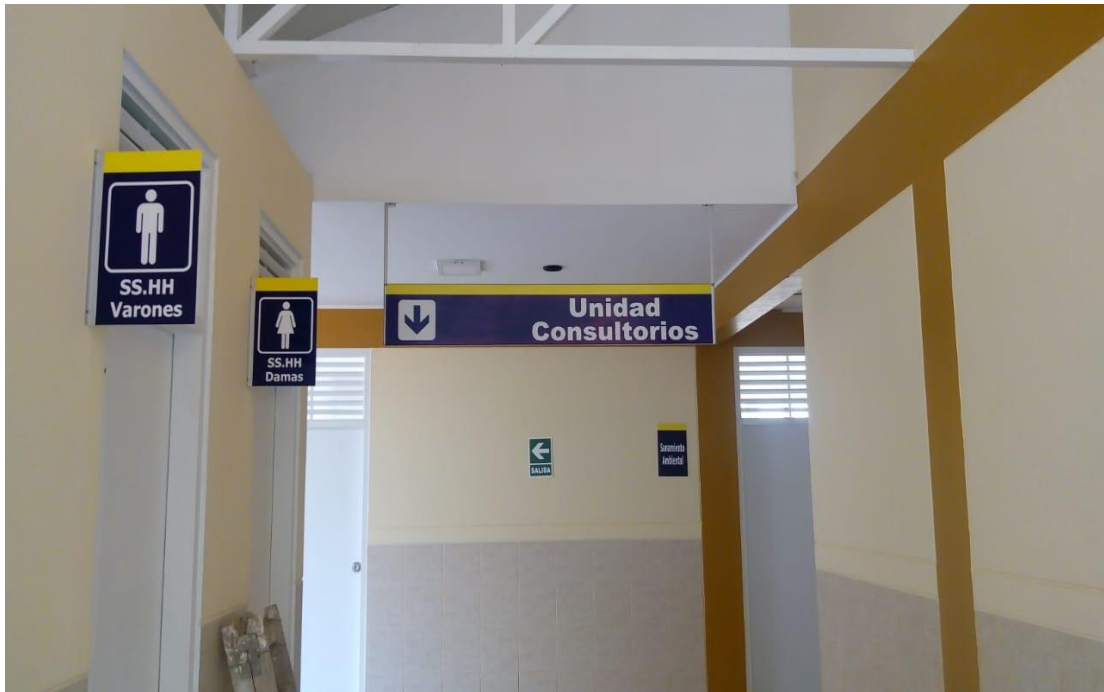
Figura 14. Culminación de los trabajos en interiores del Módulo A Fuente: Elaboración Propia
