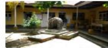
Capilla deteriorada y falta de tratamiento paisajístico.
