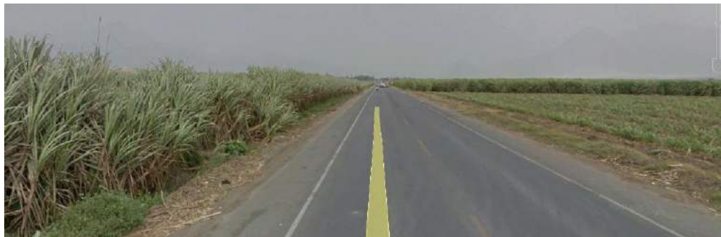
Figura 27. Vista de la vía industrial del terreno 3
