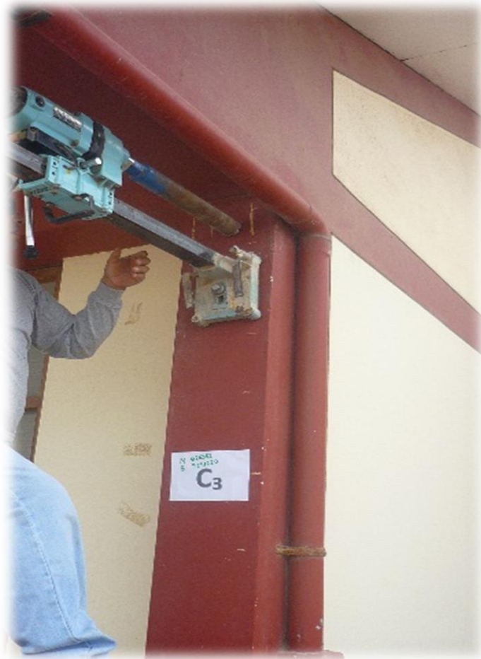
Foto 08. Broca tubular para extraer corazones de diamantino (núcleos de concreto)
