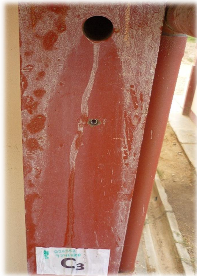
Foto 09. Extracción del núcleo de concreto
