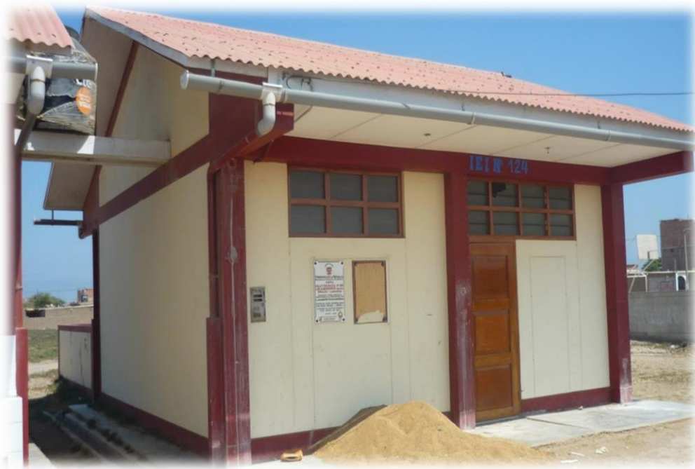
Foto 16. Reparación de las 06 columnas
