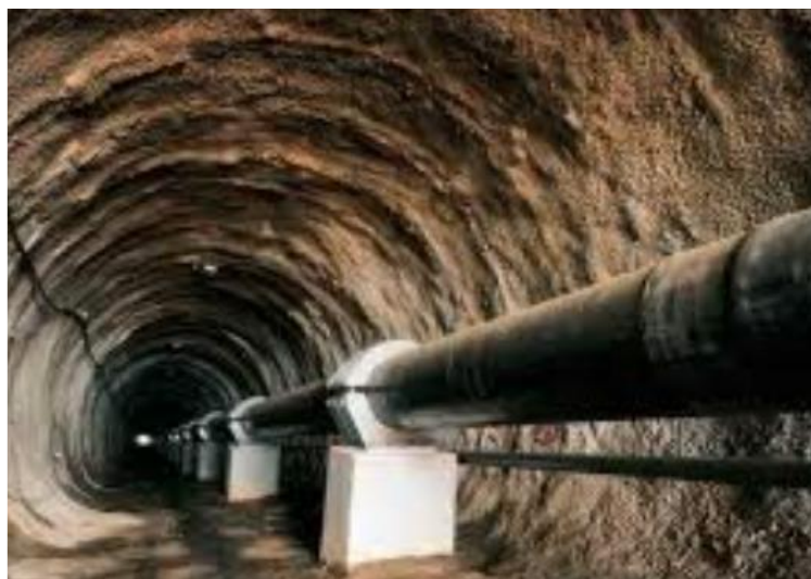
Figura N° 18. Sistema de concreto y abrazadera en tubería aérea
