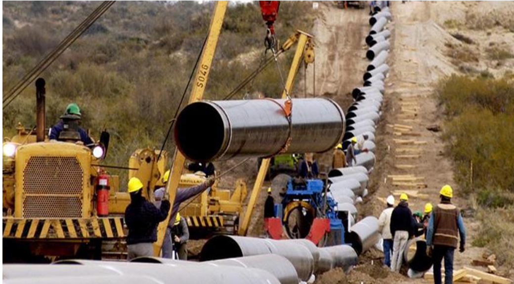
Figura N° 20. Colocación o desfile de tuberías de acero
