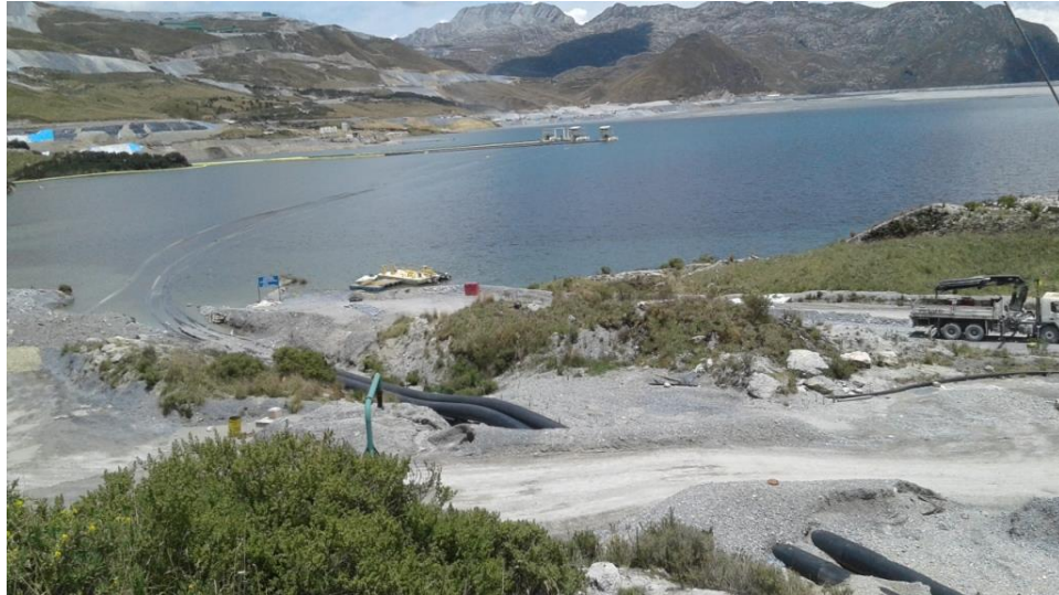
Figura N° 9. Presa de relaves
