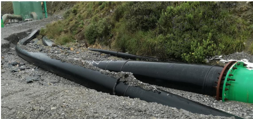
Figura N° 21. Tendido de tuberías HDPE, Ø28 y Ø42"
