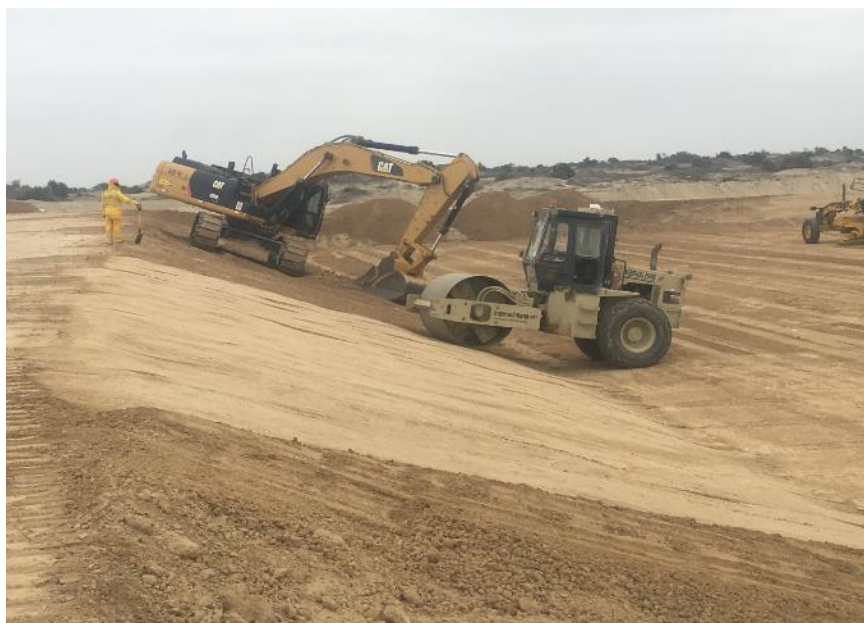
Ilustración 7 Trabajos de comparación dinámica
