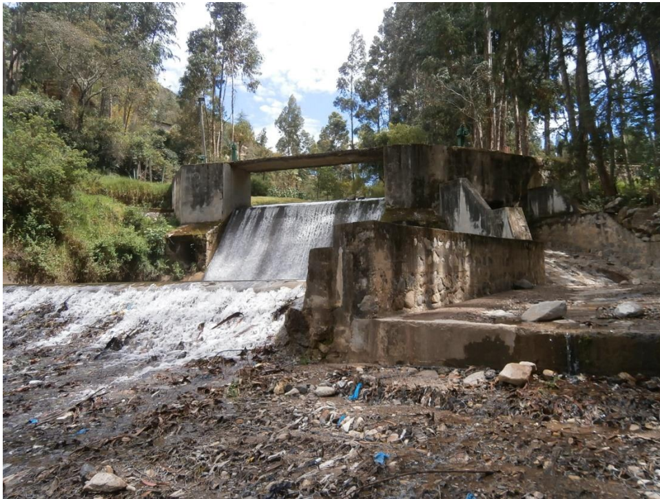
Fotografía 1 Punto de inicio Tesis Captación el Ronquillo
