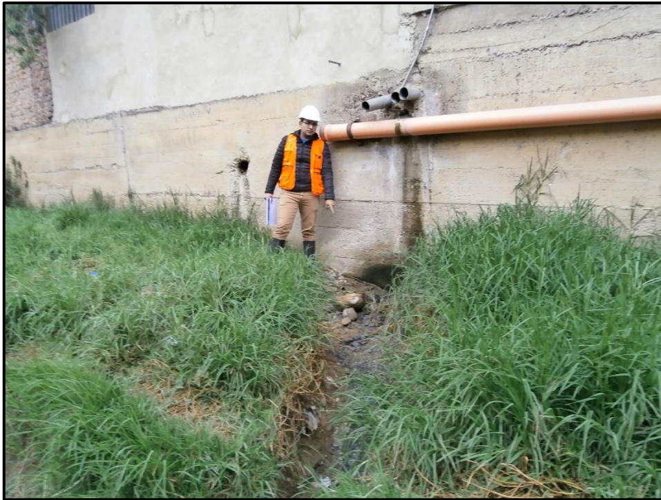
Fotografía 7 Identificación de agua residual de tipo domestico
