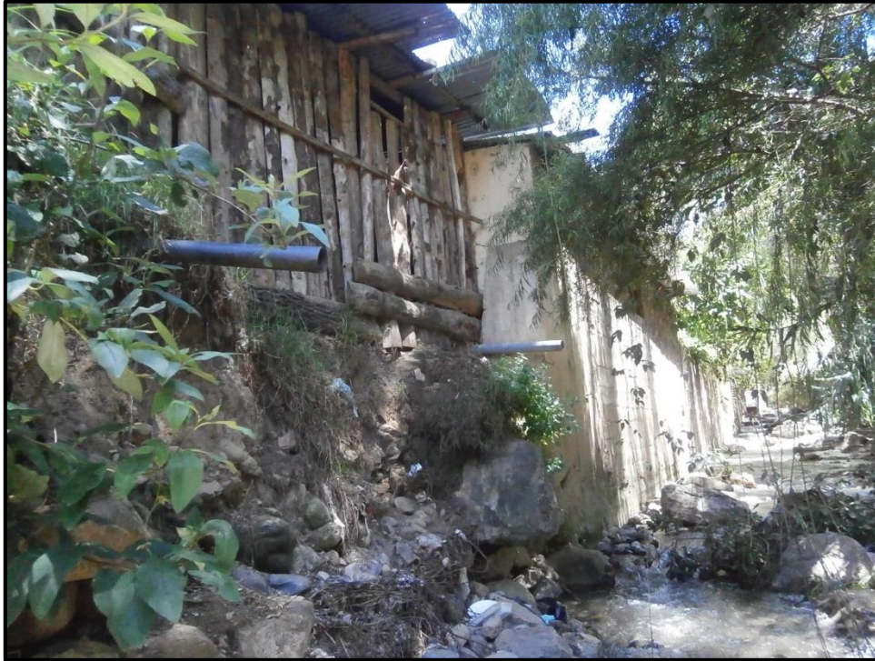
Fotografía 3 Vista de los Puntos de descarga en viviendas
