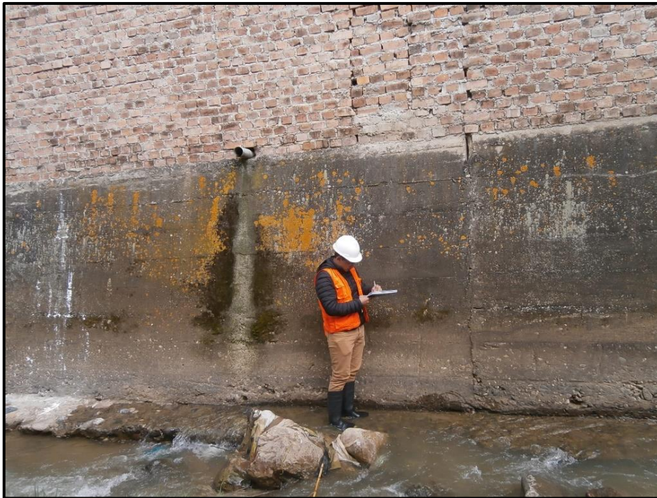
Fotografía 11 Toma de datos de los puntos de agua residual
