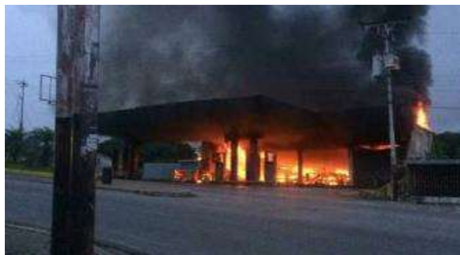
Ilustración n.º 71 Explosión de materiales en Estación de Servicios
