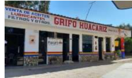
Fuente: Estación de Servicios Huacariz
