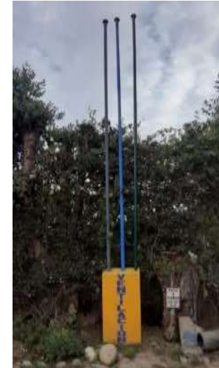
Fuente: Estación de Servicios Huacariz
