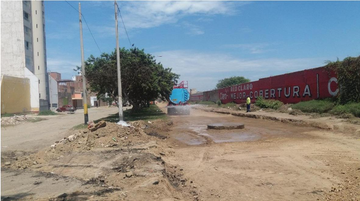
*Foto N°03: Riego de agua con camión cisterna*
