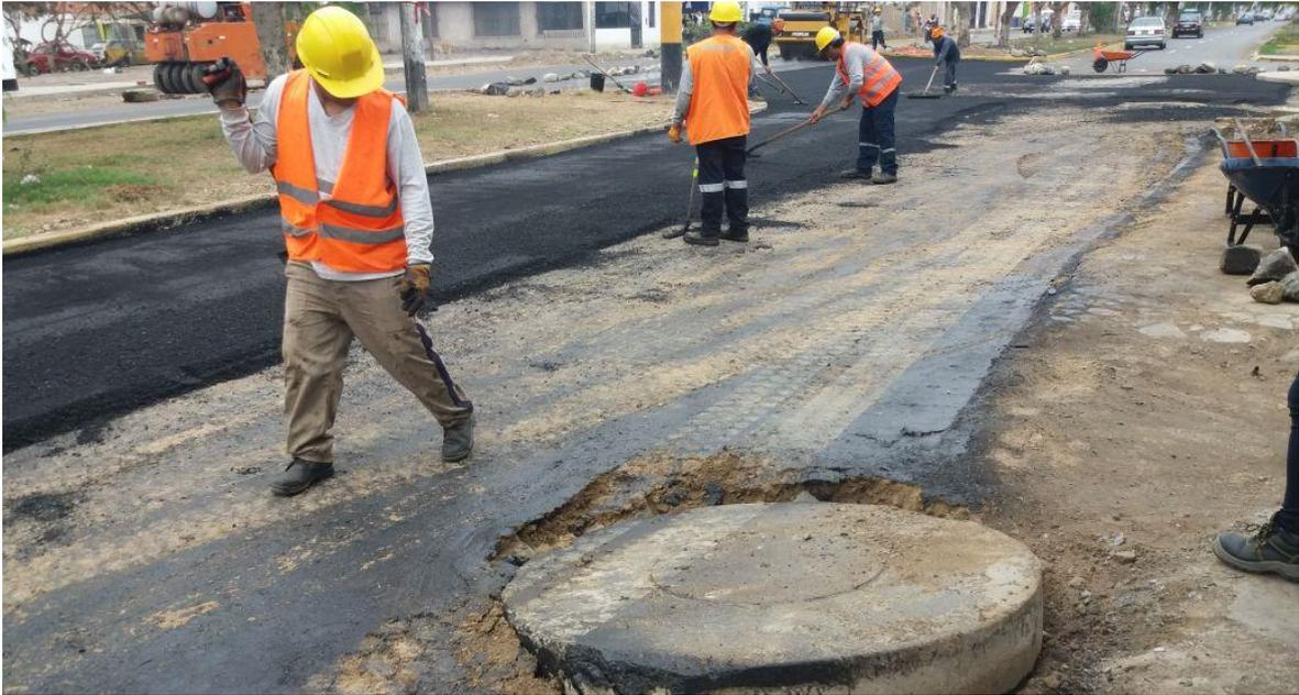
*Foto N°30: Colocación de carpeta asfáltica*
