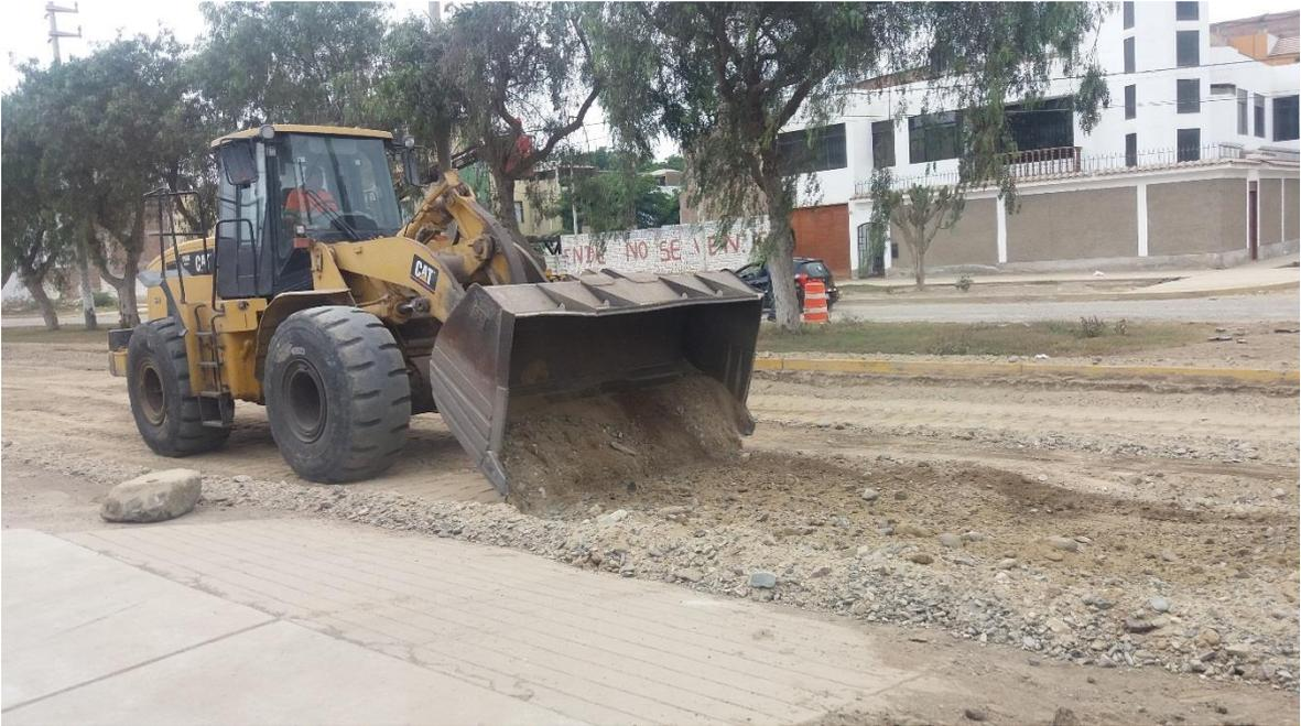
*Foto N°20: Corte de base existente con cargador frontal*
