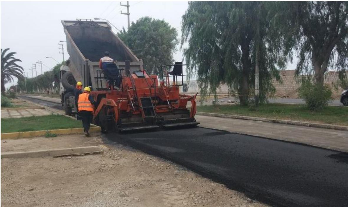
*Foto N°29: Colocación de carpeta asfáltica*
