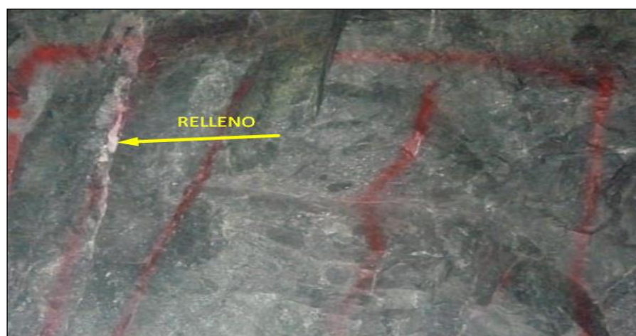
Figuras 4: Relleno de la discontinuidad, mapeo geomecánico de la rampa Karent.
