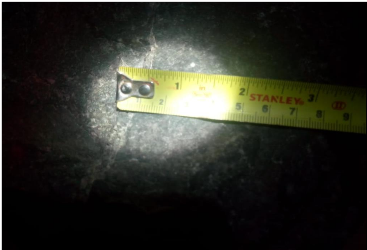
Figuras 53: Mapeo geomecánico de la rampa Karent.
