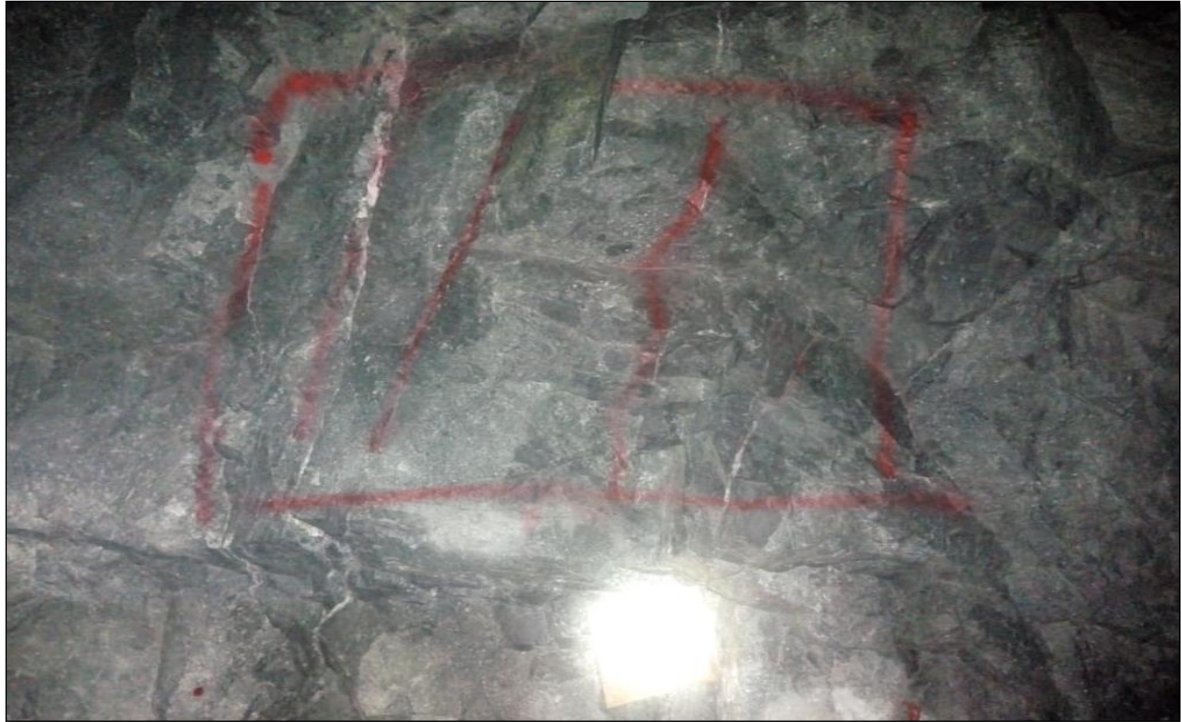
Figuras 52: Mapeo geomecánico de la rampa Karent.
