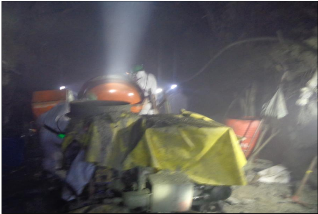
Figuras 61: Instalación del equipo Ocmer para el lanzado de Shotcrete.
