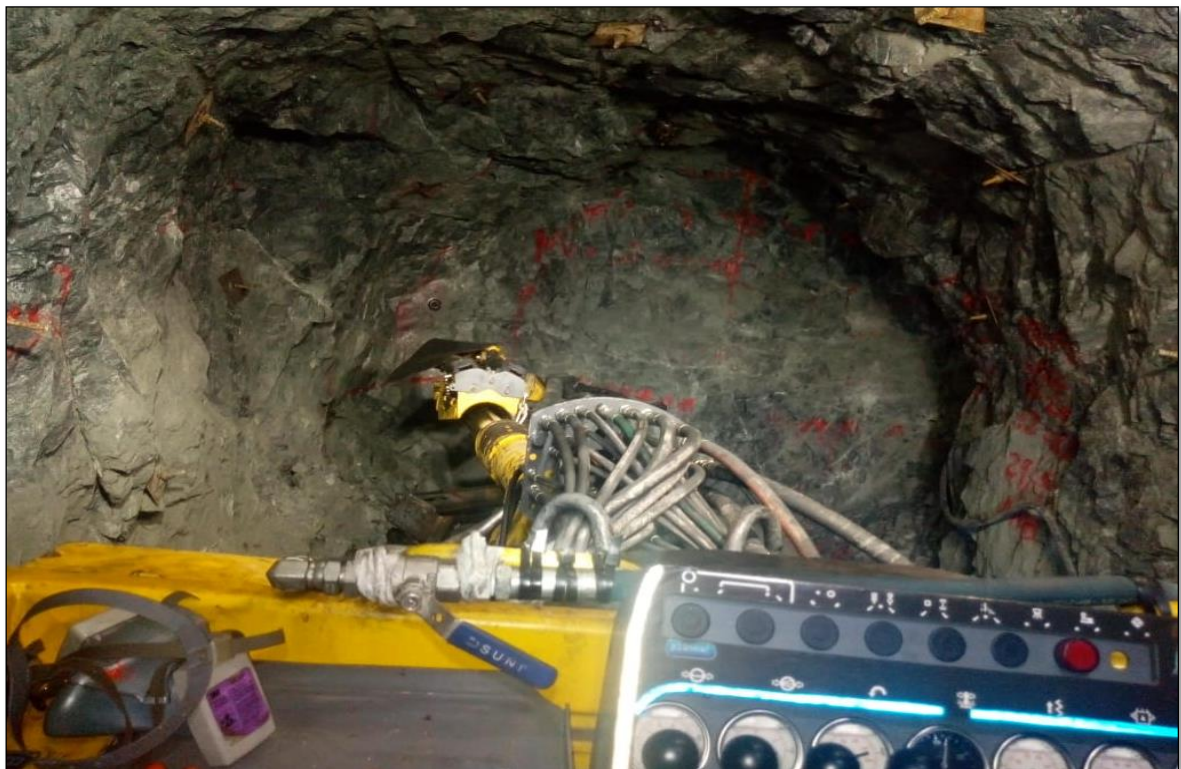
Figuras 60: Sostenimiento de la rampa Karent con perno helicoidal
