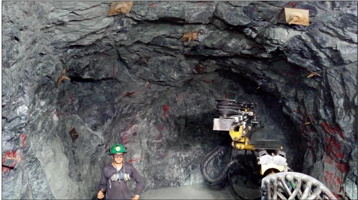
Figuras 59: Sostenimiento de la rampa Karent con perno helicoidal.
