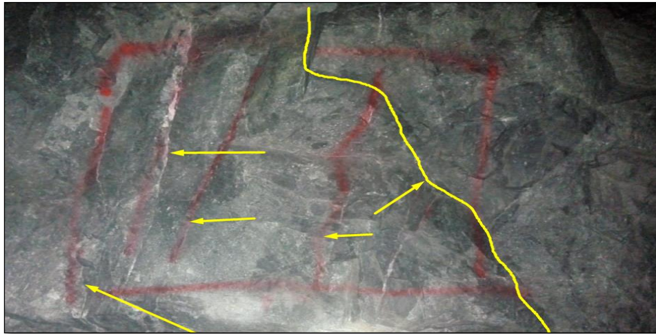
Figuras 2: persistencia de la discontinuidad, mapeo geomecánico de la rampa Karent.
