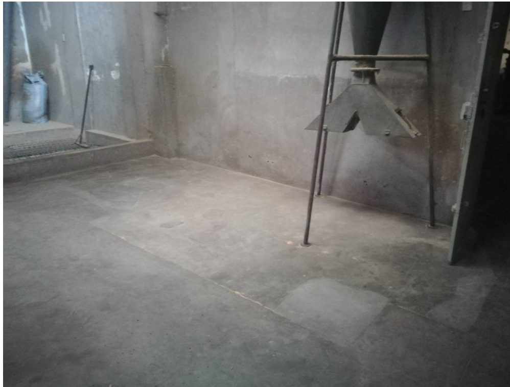
Figura 50. Zona limpia en almacén general
