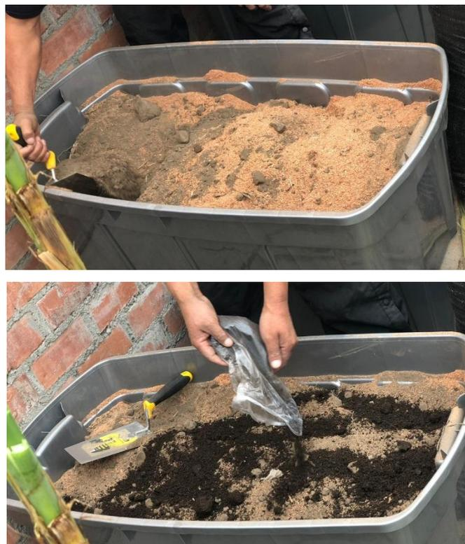
*Figura 5. Preparación del filtro sustrato*
