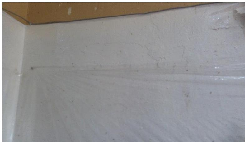
Figura 7: *Las superficies de las paredes no son lisas.* (DS N°007-98-SA y su modificatoria DS 038- 2014-SA, Instalaciones de las fábricas, Estructura y acabados, Art 33)
