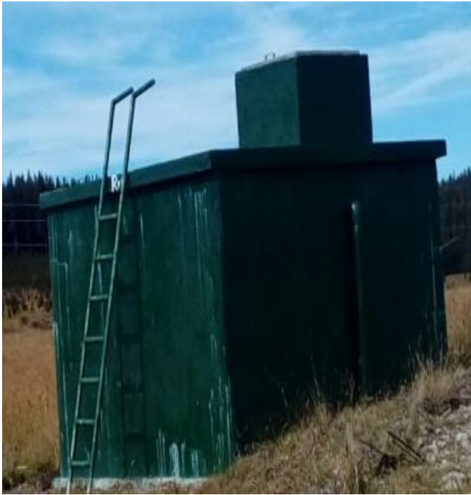
Figura 25. Captación de agua.
