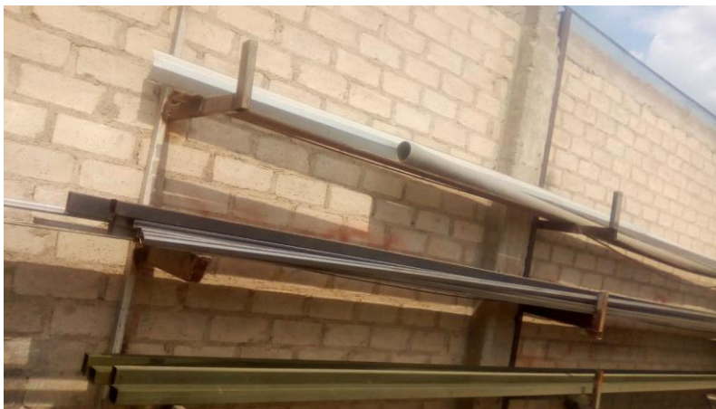
Figura 5: Material en mal estado
