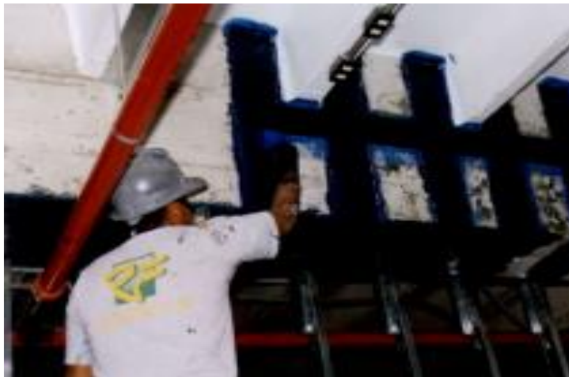
Figura 24. Reforzamiento de viga Edificio Chocavento – San Isidro.
