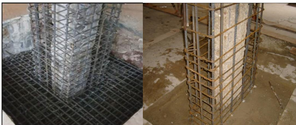
Figura 69. Reforzamiento con encamisado acero concreto.
