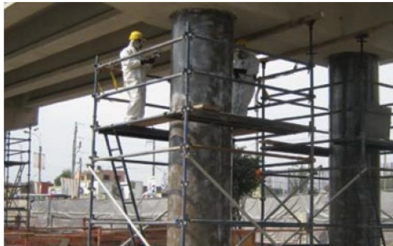
Figura 26. Reparación con CFRP columna del tren eléctrico
