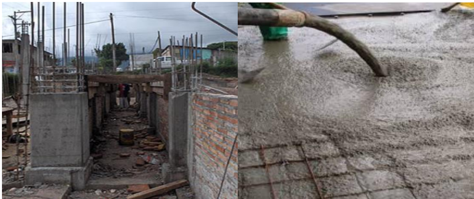
Figura 2. Muestra de concreto armado en columnas y losa.
