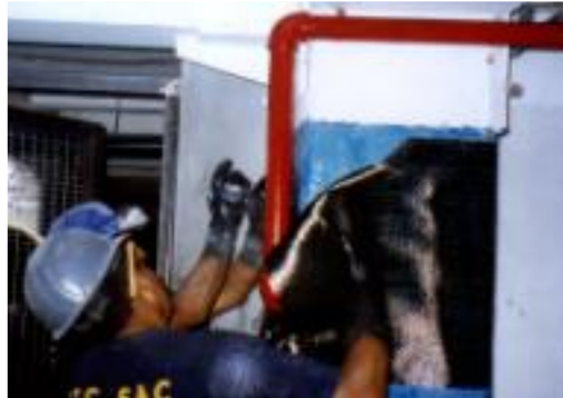
Figura 25. Aplicación de fibra en columna. Plaza Veá Higuiereta Surco.
