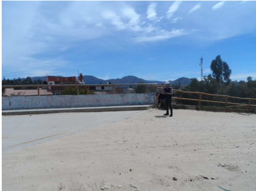
Figura 90 Medición del Ancho de calzada del puente Huacariz.
