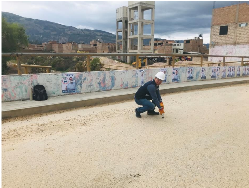
Figura 83 Ensayo de Esclerometría del puente Huacariz, en diversos puntos.
