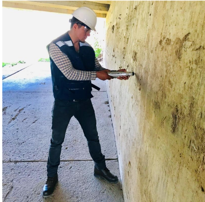
Figura 85 Ensayo de Esclerometría, varios puntos - aletas.
