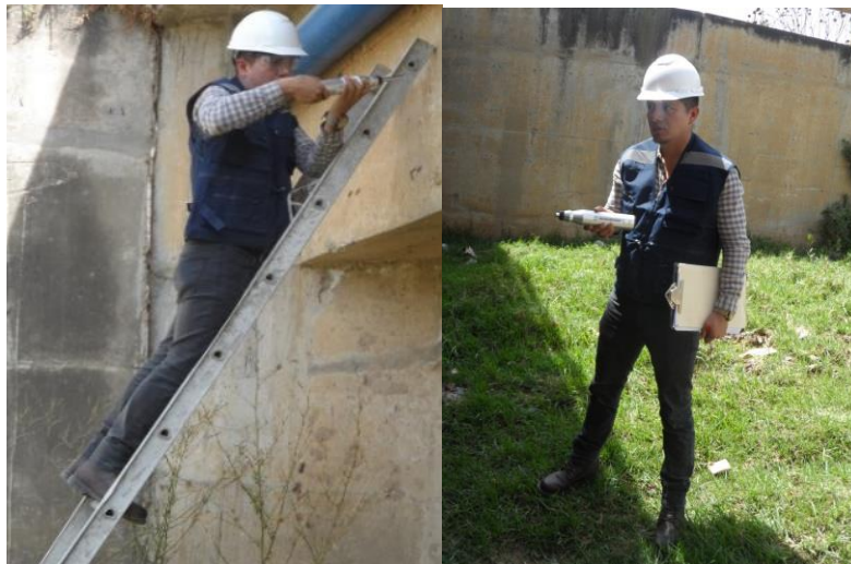
Figura 10 Ensayos de esclerometría en elementos estructurales del puente.
