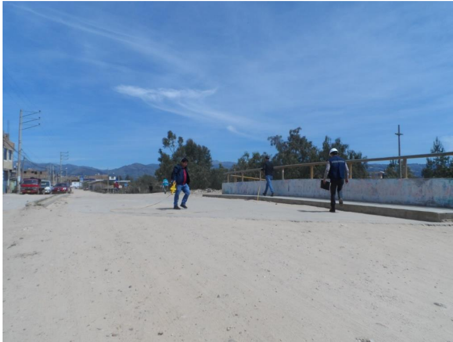
Figura 91 Medición de la luz del puente Huacariz, entre apoyos.
