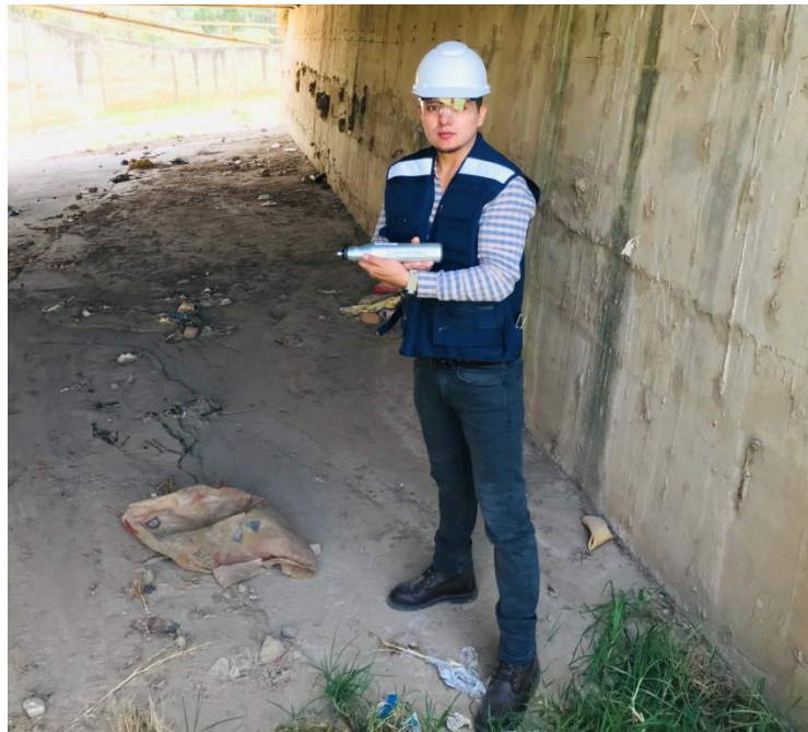
Figura 86 Ensayo de Esclerometría, varios puntos - aletas.
