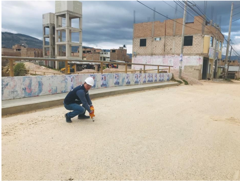
Figura 82 Ensayo de Esclerometría del puente Huacariz.
