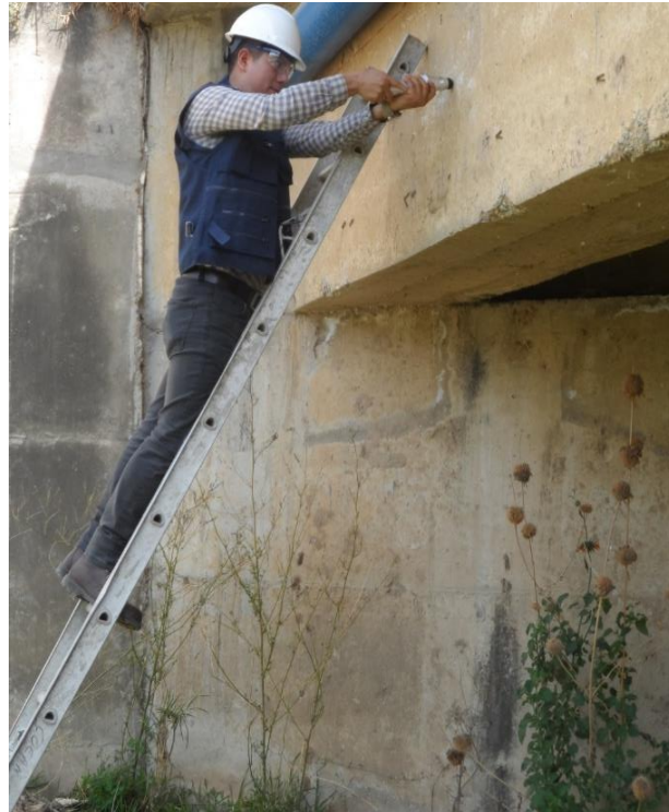
Figura 87 Ensayos de Esclerometría – con escalera de apoyo.
