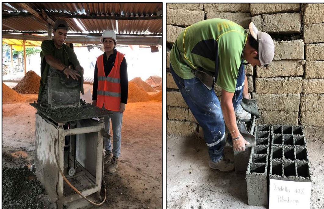
Foto N° 14: Preparación de mezcla para la elaboración de Ladrillo para losa aligerada con y sin adición de poliestireno.
