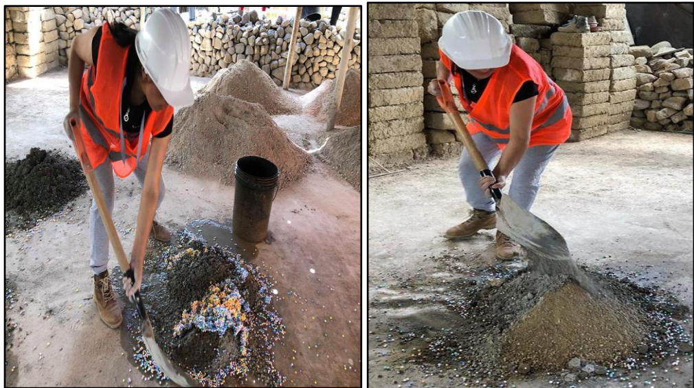
Foto N° 12: Preparación de mezcla para la elaboración de Ladrillo para losa aligerada con y sin adición de poliestireno.
