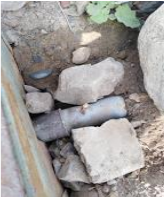
52. Accesorios del caserío de Cajamarca-Simbal III
