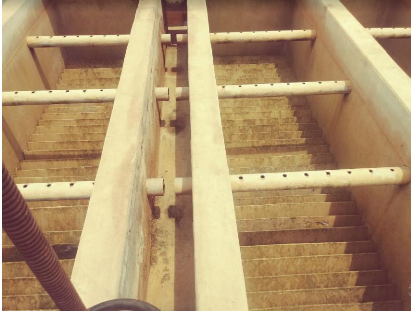
39. Cimentación y estructura de Simbal II
