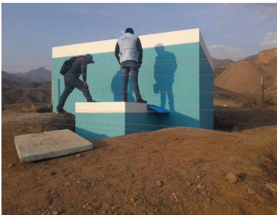
42. Cimentación y estructura del caserío Cajamarca-Simbal I
