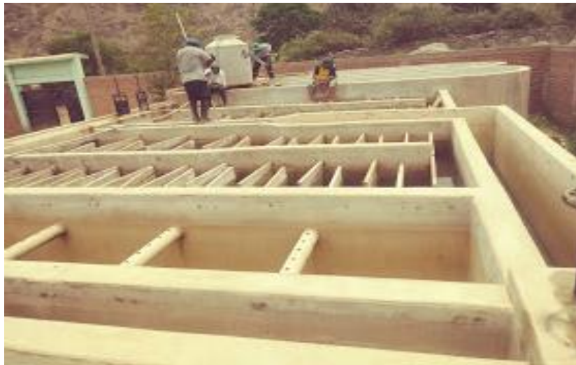
40. Cimentación y estructura de Simbal II
