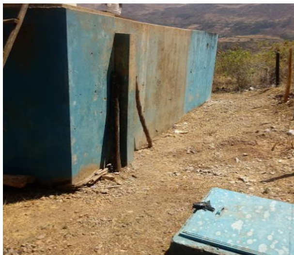
19. Cimentación y estructura del distrito de Lucma I
