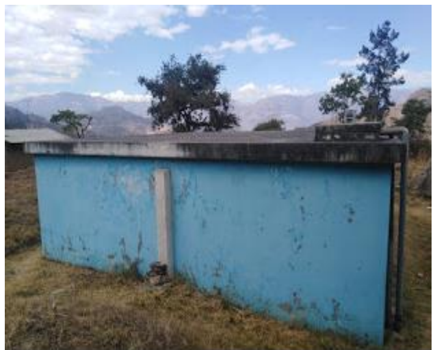
36. Infraestructura y cimentación de Huaranchal II
