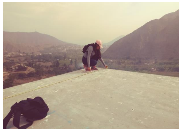
43. Cimentación y estructura del caserío de Cajamarca-Simbal II
