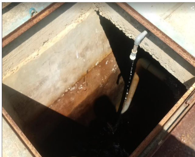
21. Cimentación y estructura del distrito de Lucma III
