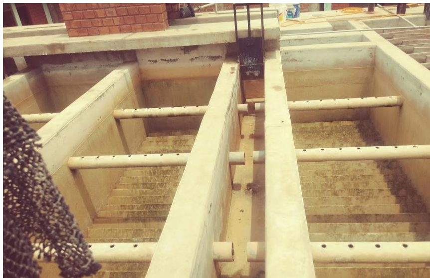
38. Cimentación y estructura de Simbal I
