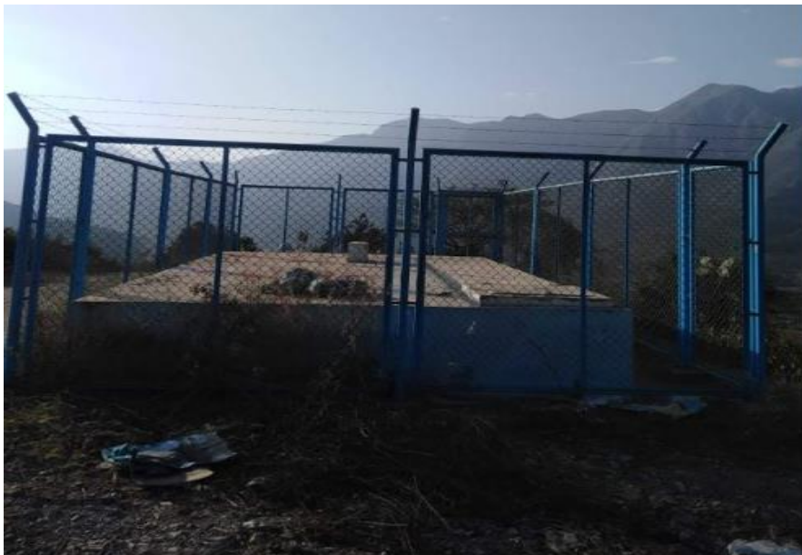
7.Arquitectura distrito de Poroto II
