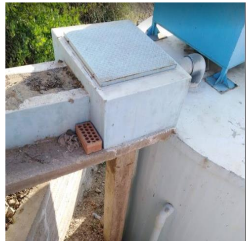
5. Captación distrito de Poroto II
