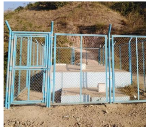
3.Cimentación y estructura del distrito de Poroto II
