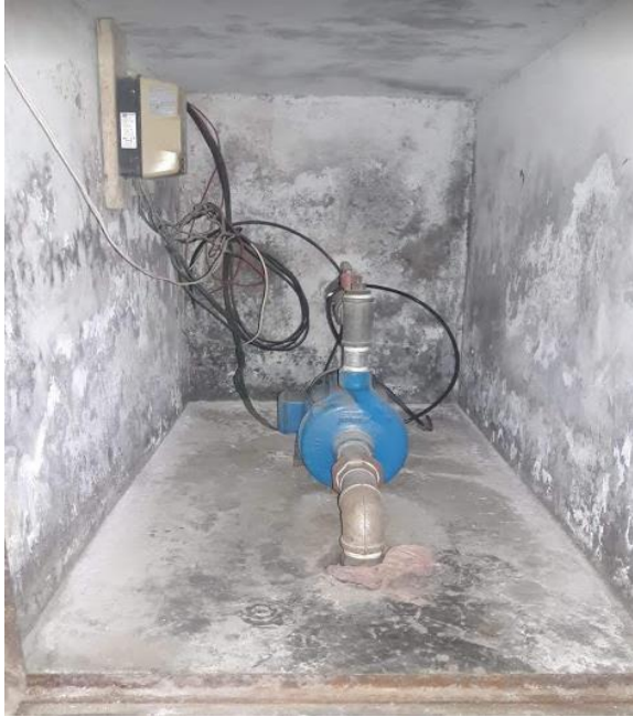
50. Accesorios del caserío de Cajamarca-Simbal I
