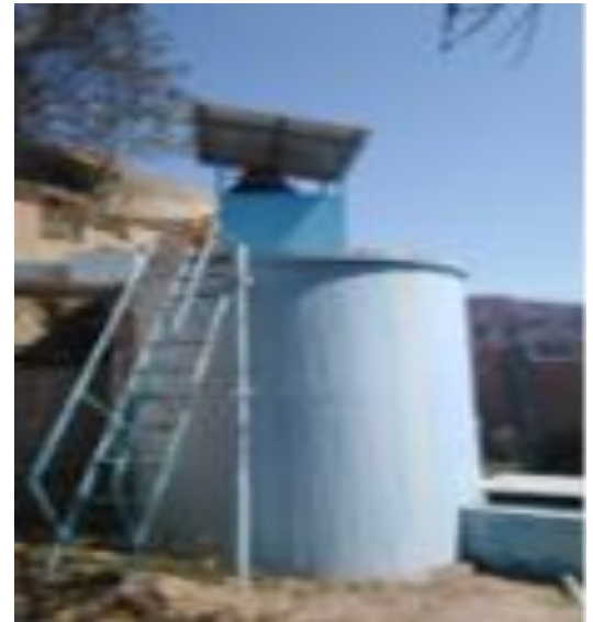
2.Cimentación y estructura del distrito de Poroto
