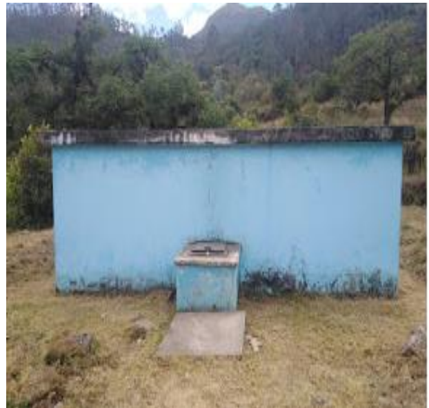
35. Infraestructura y cimentación de Huaranchal I
