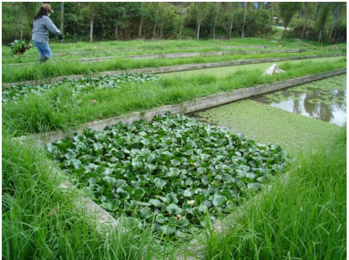
Fig.02 pozas para tratamiento de aguas residuales con plantas acuáticas (jacintos)
