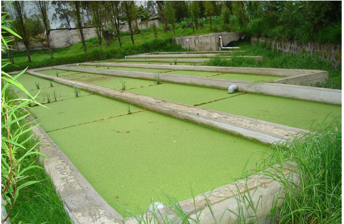
Fig.03 pozas para tratamiento de aguas residuales con plantas acuáticas (lenteja de agua).
