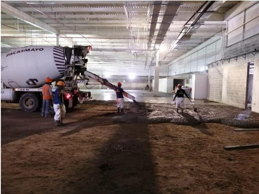
*Figura 25: Vaciado de concreto premezclado en Chulucanas.*
