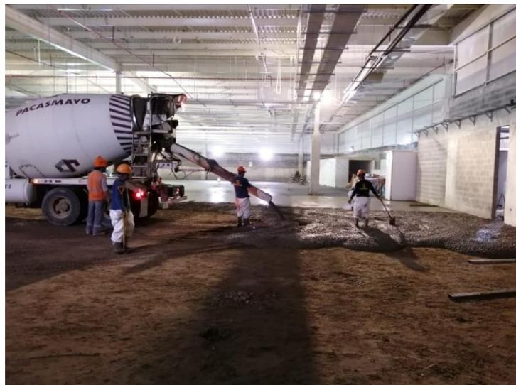
Figura 1: Vaciado de concreto pre mezclado
