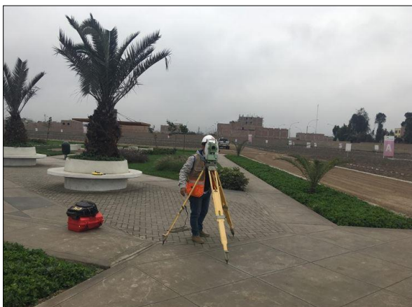
Figura 26. Replanteo de buzones con estación total.
