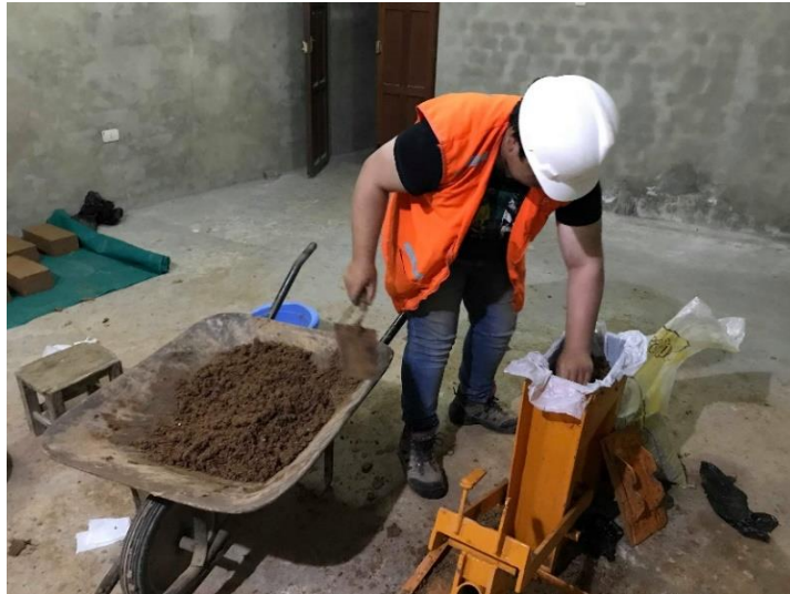
Figura 16 Colocación de la mezcla en la máquina CINVA RAM
