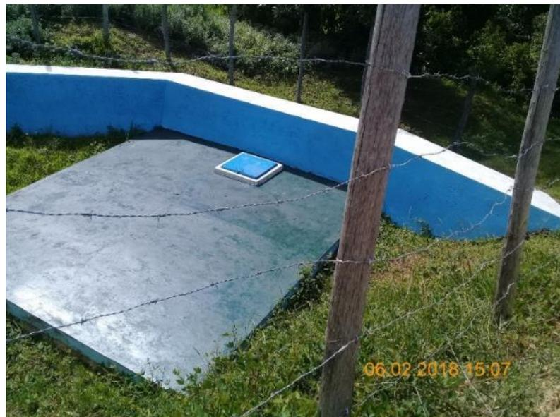
*Ilustración 13: Captación Pajuro 2, sin mantenimiento.*
