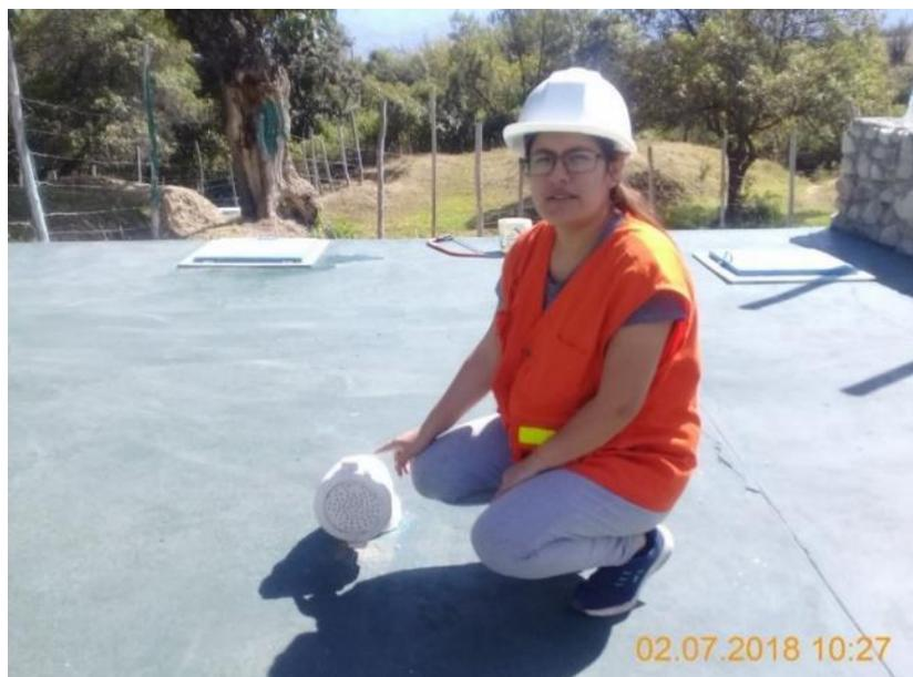
*Ilustración 9: Verificación de tapas de ventilación y tapones.*
