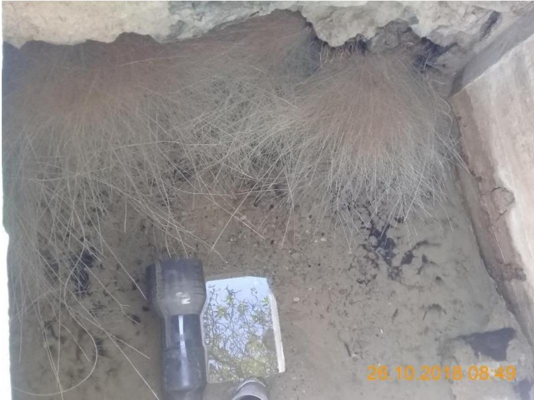
*Ilustración 24: Presencia de raíces al interior de la captación*
