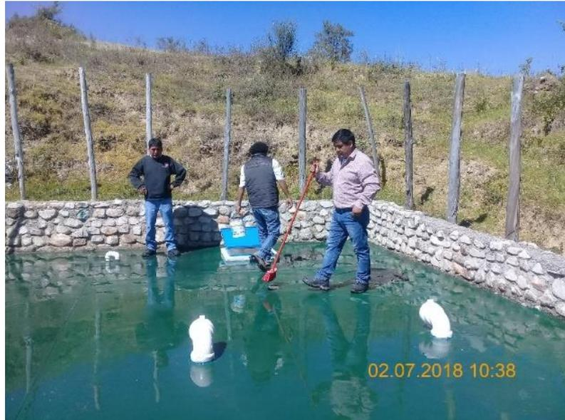
*Ilustración 10. Limpieza de Captación Pajuro 1, se limpió con agua toda la superficie.*
