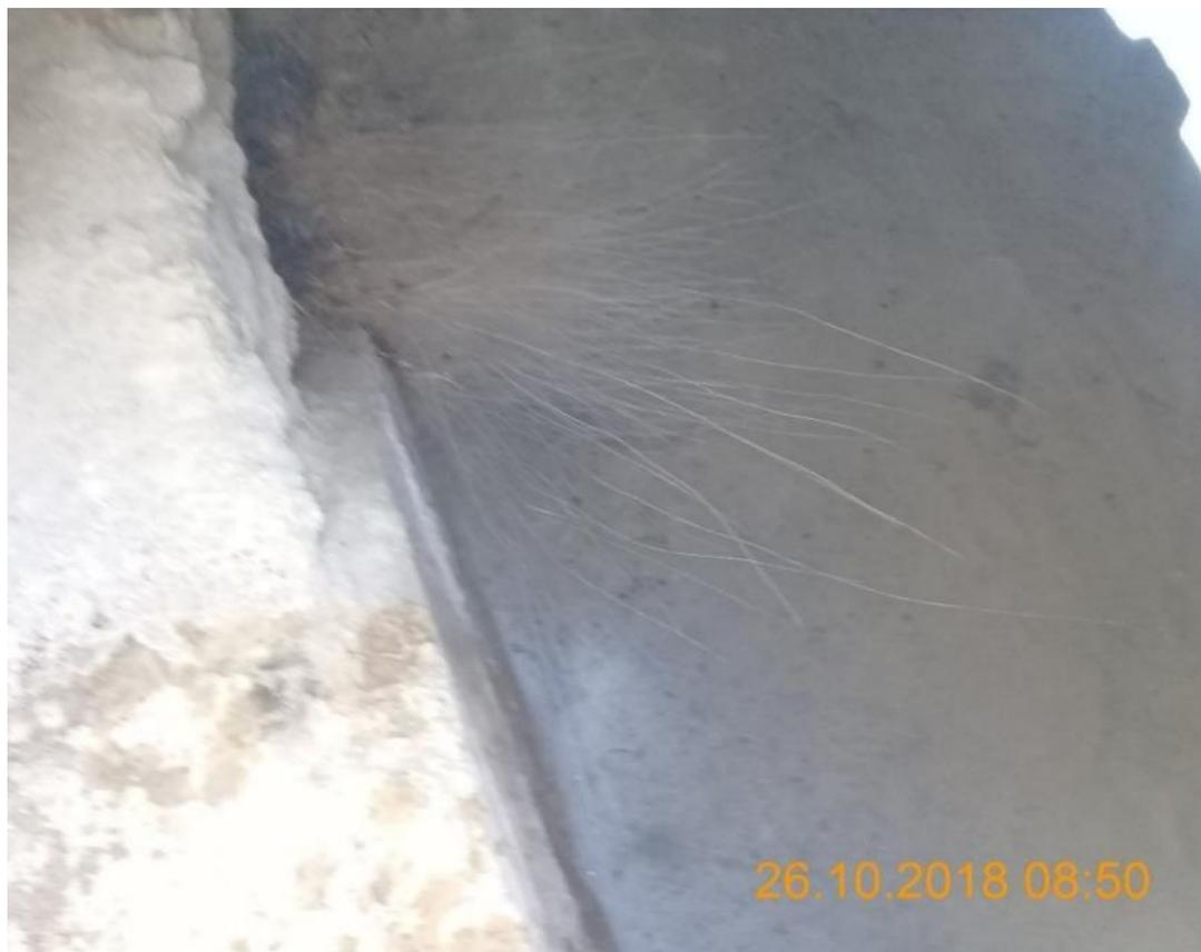
*Ilustración 25: Interior de Captación Pajuro 2, presencia de raíces en la captación por falta de mantenimiento*
