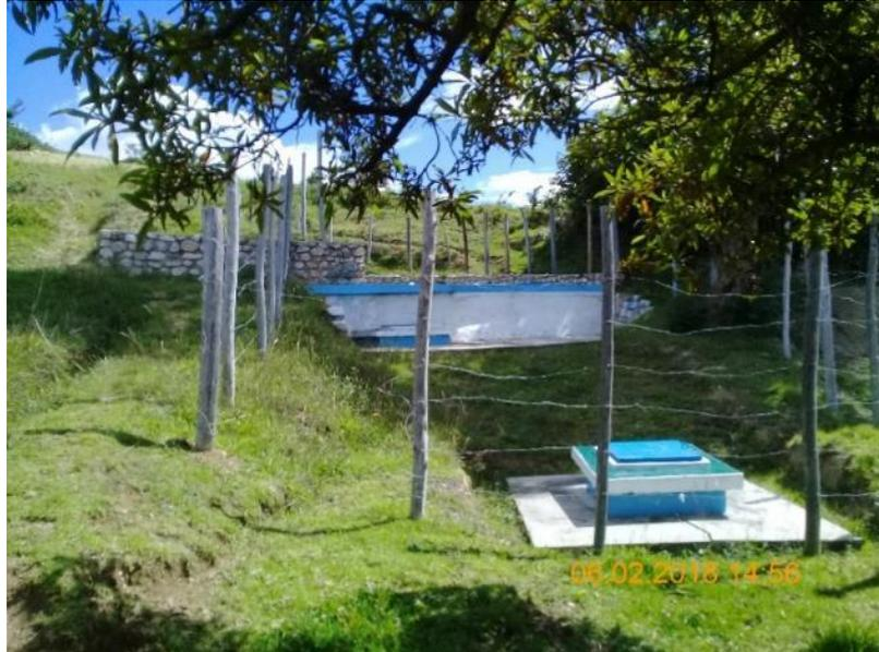
*Ilustración 12: Cerco Perimétrico Captación Pajuro 1, sin seguridad.*
