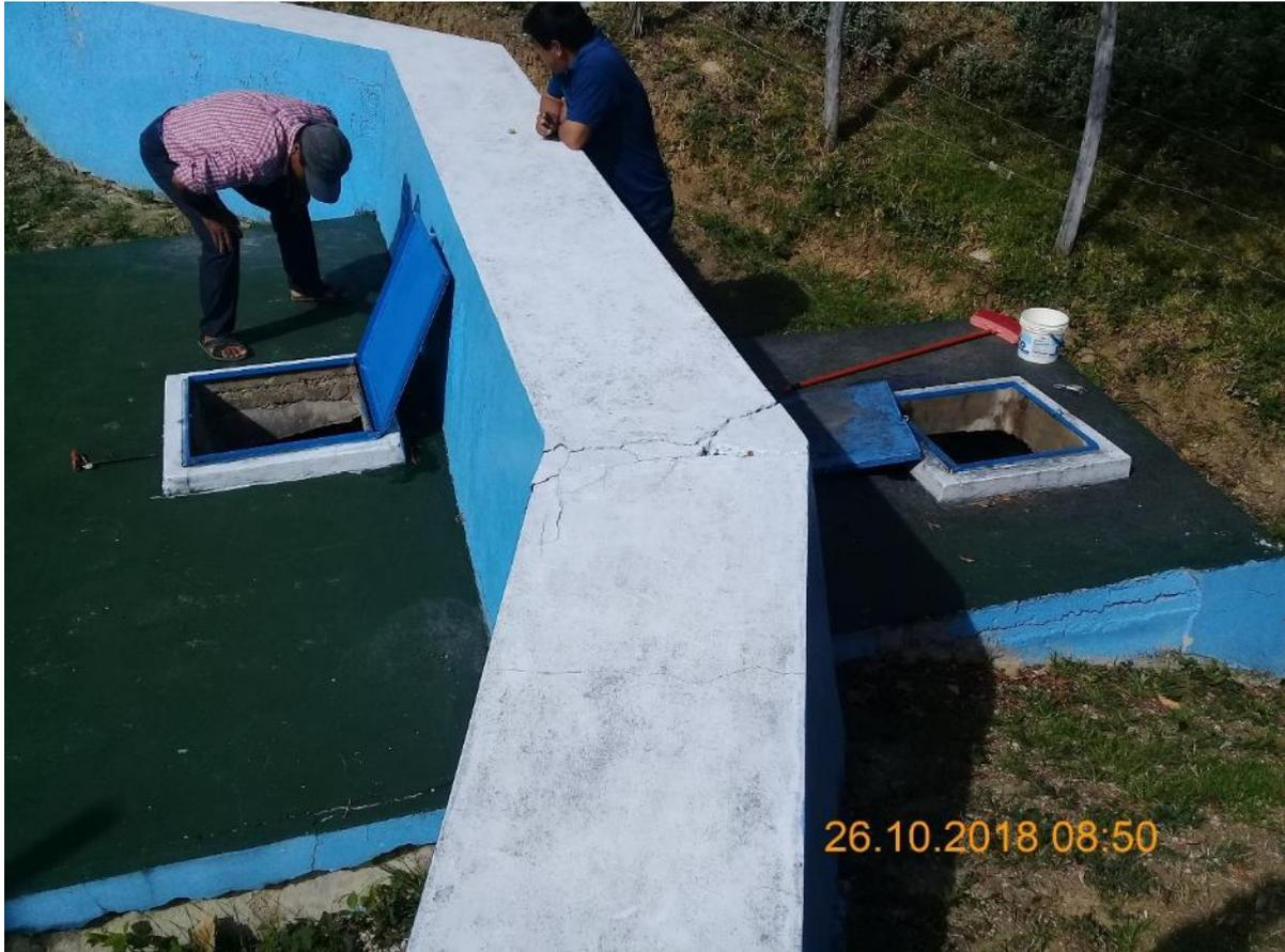
*Ilustración 28: Verificación de la Limpieza, se espera que el agua limpie algunos residuos restantes de la limpieza antes de volver a colocar las tapas.*
