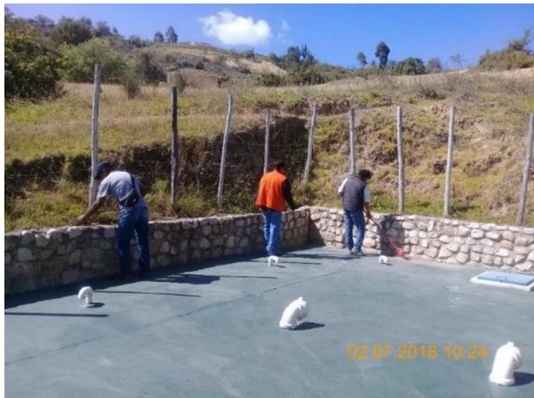
*Ilustración 7: Limpieza Externa de la Estructura, eliminación de plantas de su perímetro*
