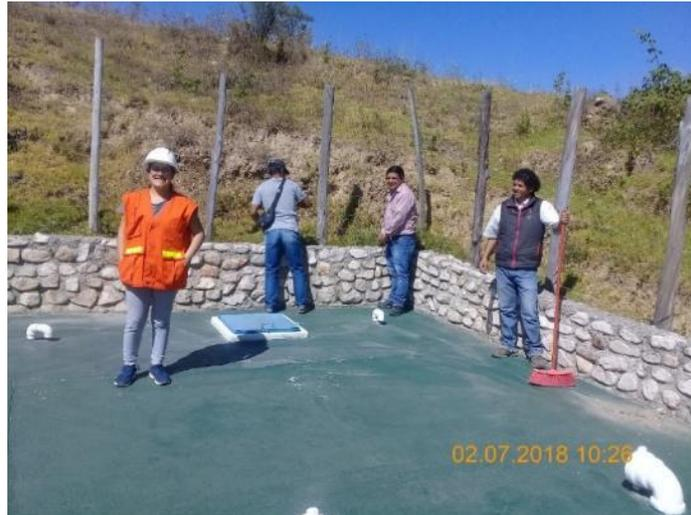
*Ilustración 8: Limpieza de la estructura captación Pajuro 1, barrido de superficie*
