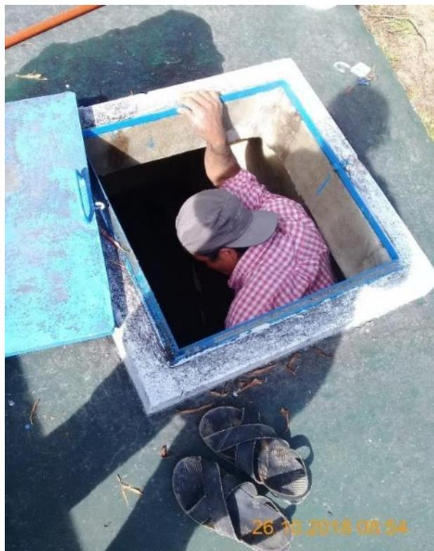
*Ilustración 21: Limpieza de Captación Pajuro 2, el personal encargado ingresa a la captación sin ningún tipo de EPP*
