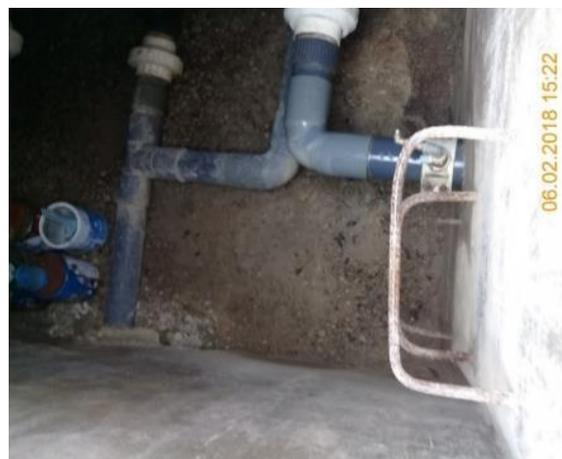
*Ilustración 6: Cámara de válvulas está saturada.*
