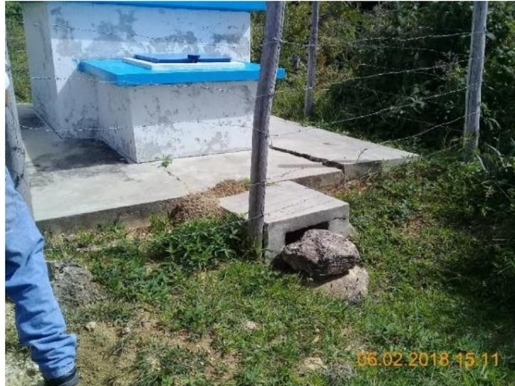
*Ilustración 4: Cámara de Reunión, la tubería de limpieza y rebose está en malas condiciones*
