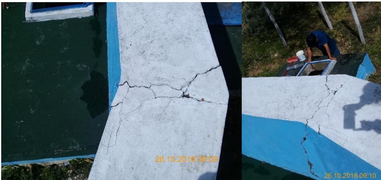
*Ilustración 29: Estructura de Captación pajuro 2, en la captación se pudieron observar diversos agrietamientos.*
