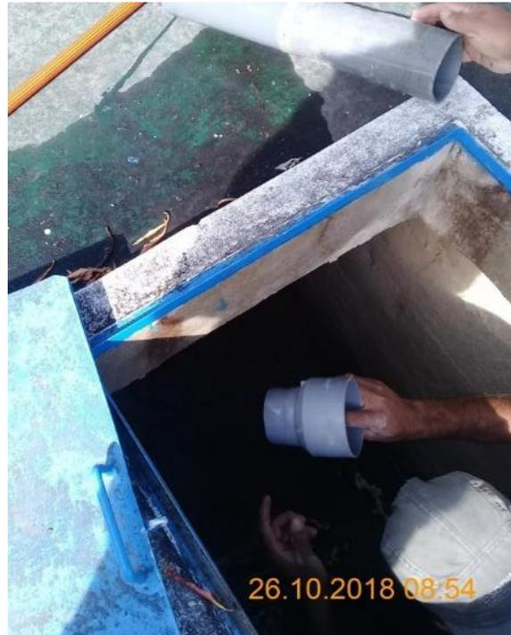
*Ilustración 22: Interior de la captación pajuro 2, se retira la tubería de rebose, lo que permite drenar toda el agua y limpiar la captación, el personal no usa EPP para ingresar a la captación.*
