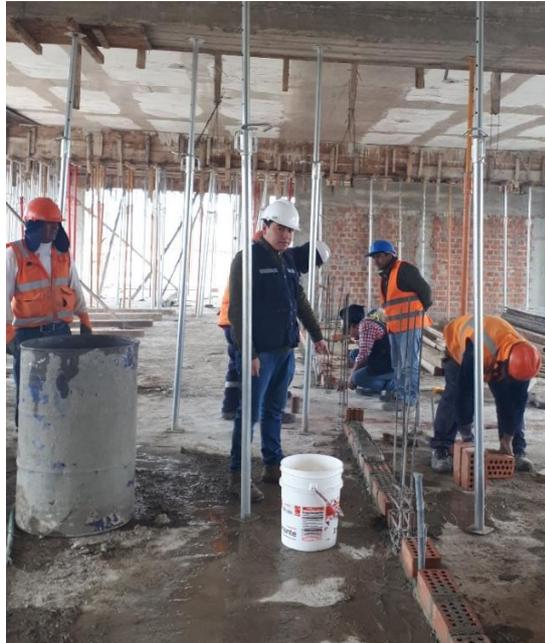
*Figura 11.* Trabajos de asentado de ladrillo
