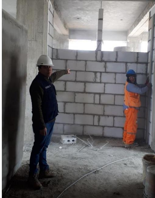
*Figura 13.* Colocación de placas p-12
